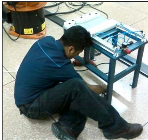
Fig. 6.6. Fijación con pernos de anclaje de la entenalla al piso.
