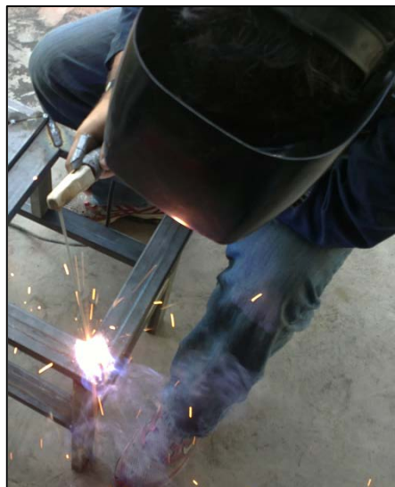
Fig. 5.2 Proceso de soldado de la estructura de soporte
