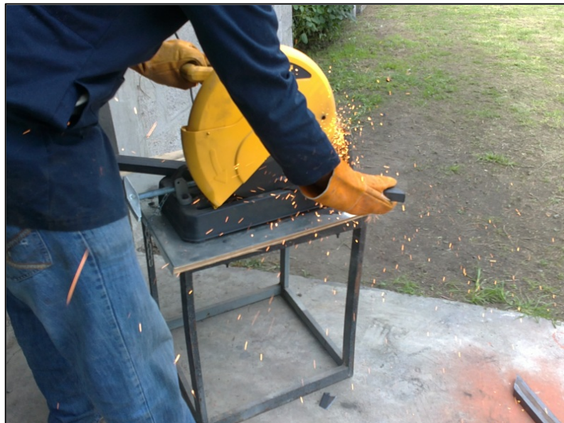
Fig. 5.1 Proceso de construcción de la estructura de soporte
