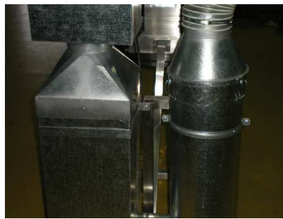
Figura. 3. 10. Contenedor para polvo con mercurio
