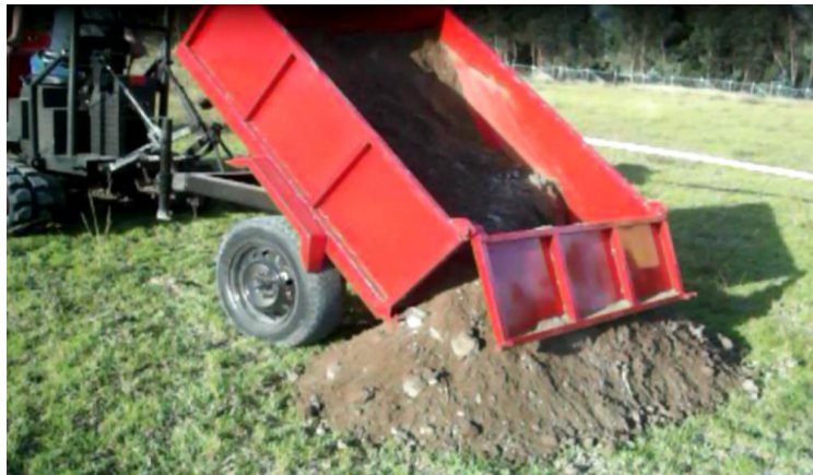
Figura 5.17. Descarga de arena
