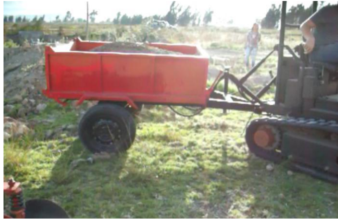
Figura 5.16. Cajón con arena
