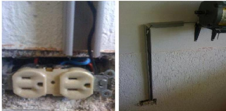
**Figura 3.23 Instalación de Tierra del Motor Baldor 3545**
