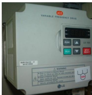
**Figura 2.13 Variador de Frecuencia LG serie iG5**
