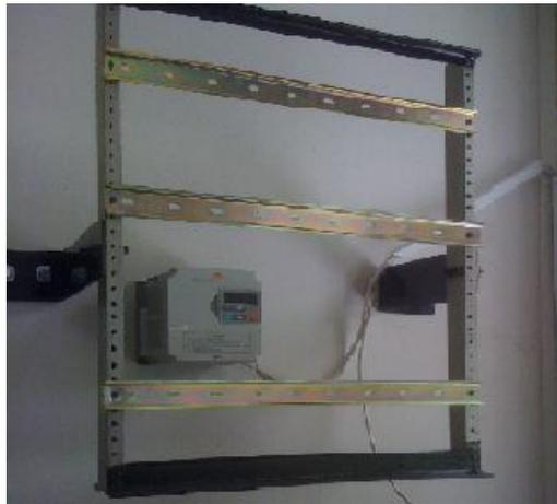
**Figura 3.21 Instalación del Variador de Frecuencia LG iG5**
