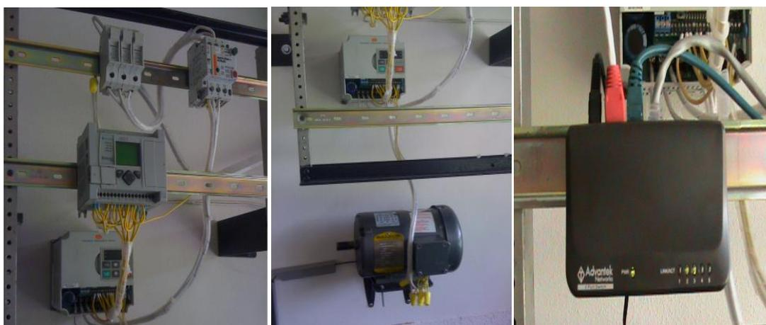
**Figura 3.25 Instalación de los Componentes de la Plataforma y su Cableado**
