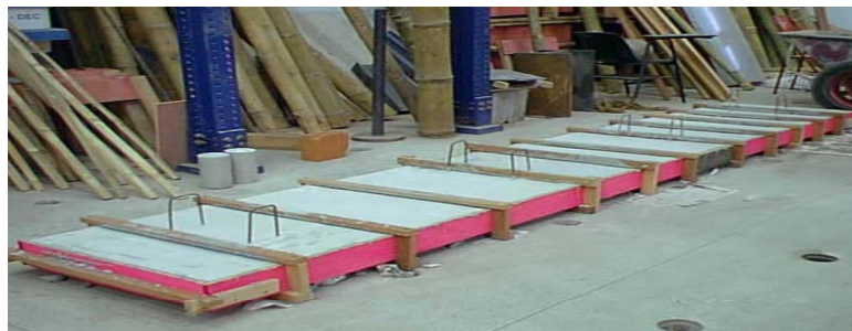
c.- Losa de Hormigón Reforzado con Bambú tras ser Fraguada
