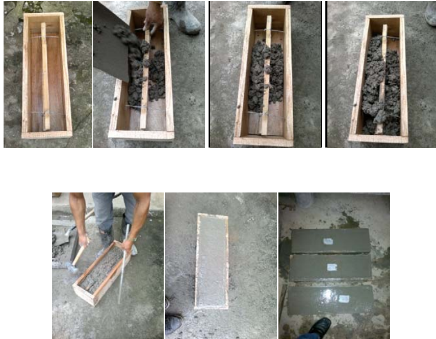
Figura 4.18: Elaboración de Vigas con Armadura de Guadua para Ensayar a Flexión (Laboratorio ASHOSUE CIA. LTDA.)
