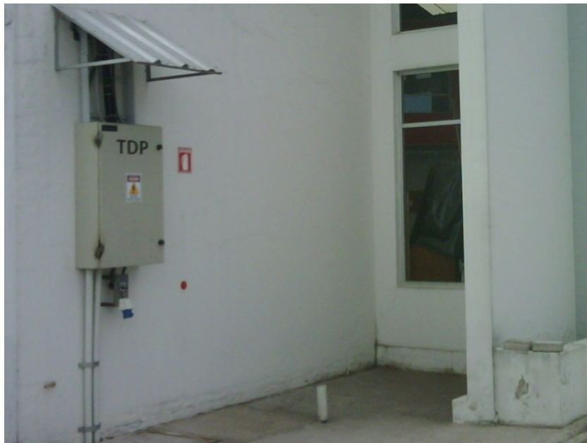
Fig. 4.1 Zona de Ubicación del Compresor.
