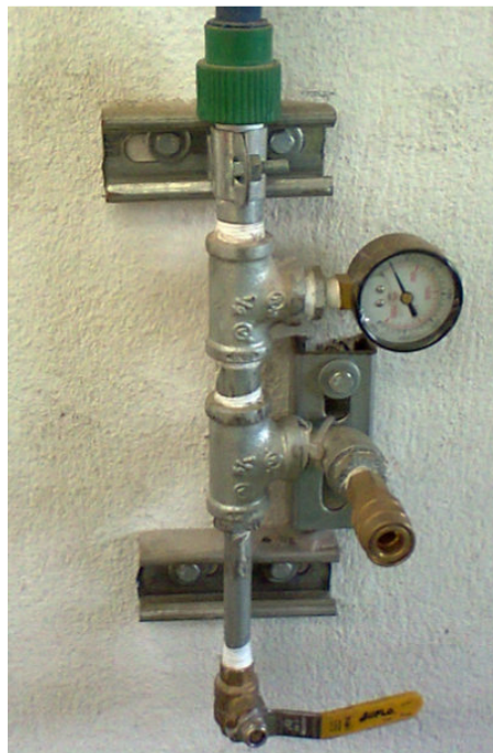
Fig. 4.15 Accesorios de Puntos de Consumo.
