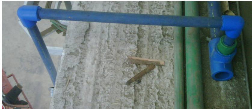
Fig. 4.11 Derivación Instalada.
