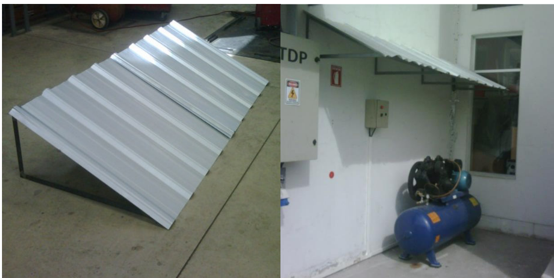
Fig. 4.3 Techo para Compresor Instalado.
