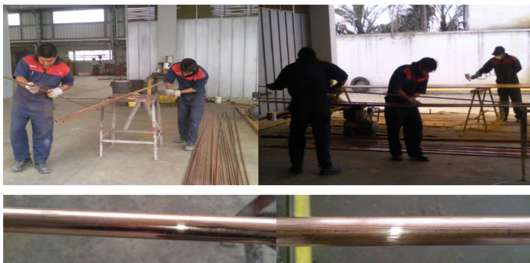
Fig. 1.3 Lijado manual de tubería de Cu
