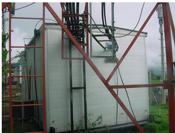
Figura. 3.42. Ventanas de cables con un número de no usados tapas de cables con conexión con la bandeja interna de cables.
