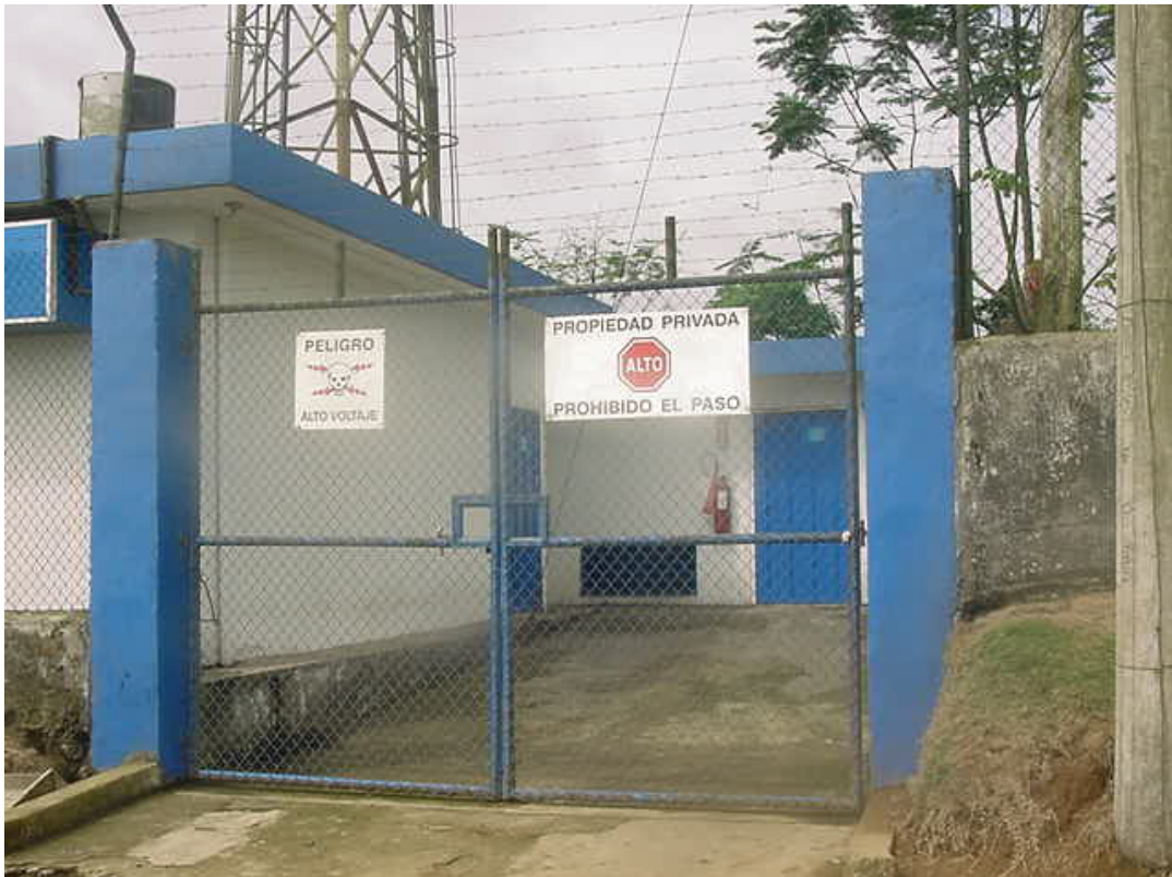
Figura. 3.47. Señales de precaución colocadas en una estación base.
