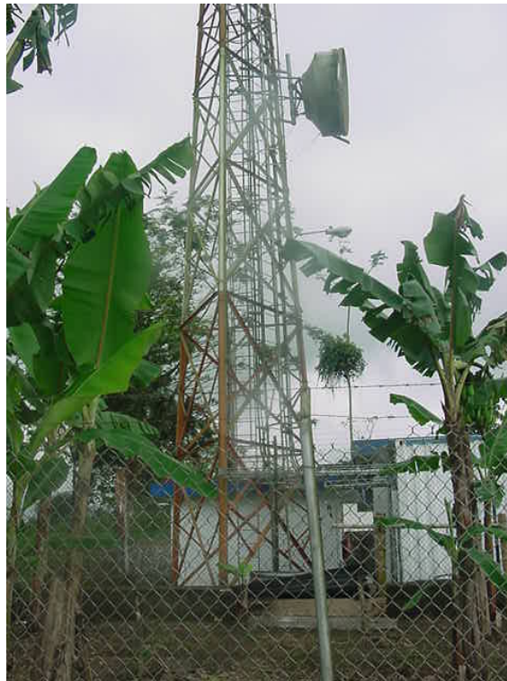
Figura. 3.38. Una cerca a prueba de personas (con postes de púas de acero) alrededor de un sitio rural.
