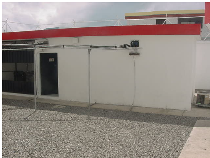
Figura. 3.45. Una estación base de concreto.
