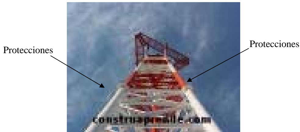
Figura. 3.20. Cuando una torre pasa de 30 m, se debe poner protecciones en las partes laterales.
