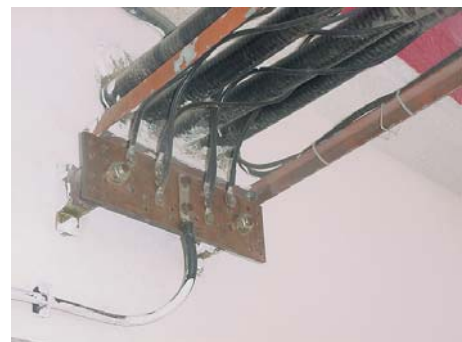
Figura. 3. 17. Barras de tierras utilizadas en distintas aplicaciones
