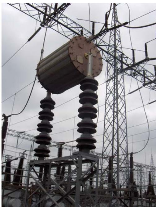
**Figura 1.14. Equipo de trampa de onda en la subestación de Quevedo**
