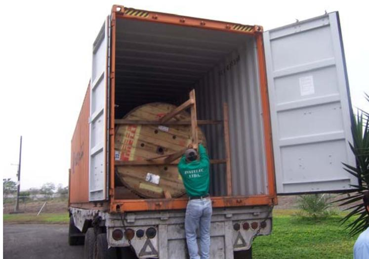
**Figura 2.11. Transporte de cable de guarda previa a su instalación**
