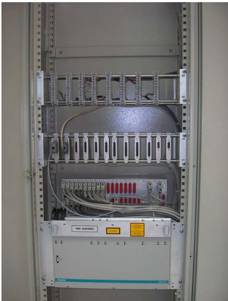
**Figura 1.33. Equipo de fibra óptica (FMX) de uso interno con capacidad de 64Kbps en la subestación de Quevedo de marca SIEMENS**
