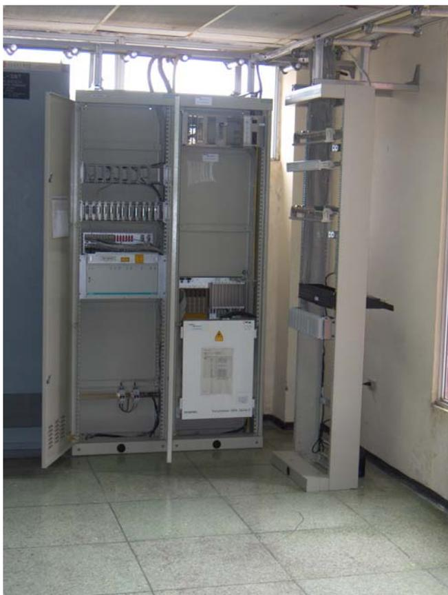
**Figura 1.32. Equipo de fibra óptica SMA-16 en la subestación de Quevedo marca SIEMENS**
