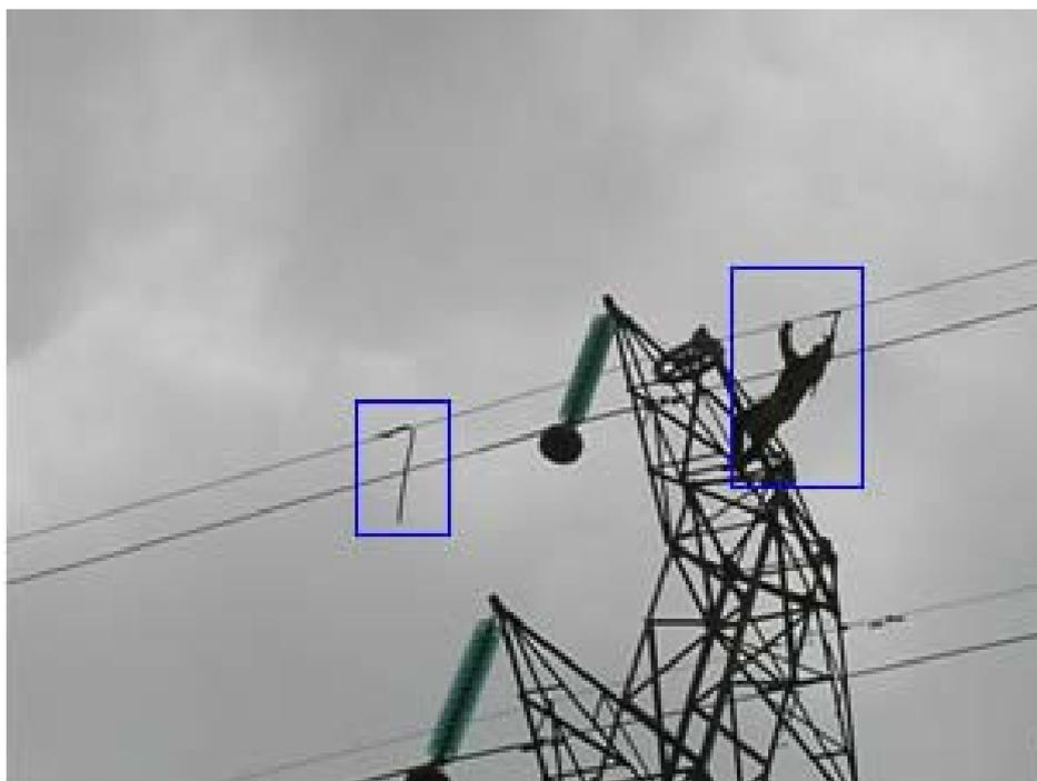
**Figura 2.18. Proceso de colocación de contrapesos en los cables de guardia**
