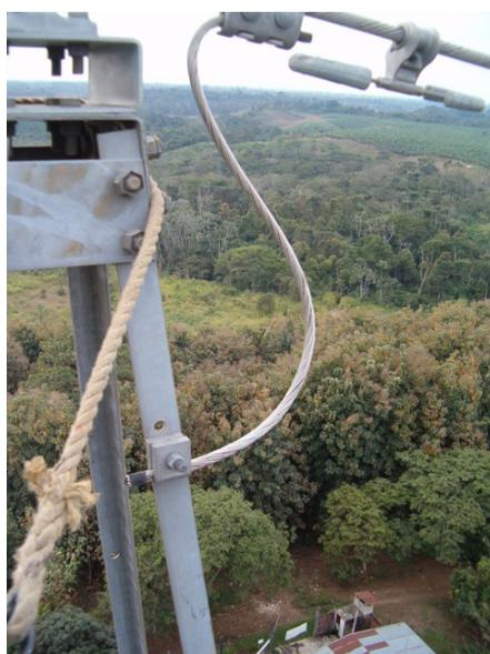
**Figura 2.17. Puesta a tierra del cable de guarda en la torre de alta tensión**
