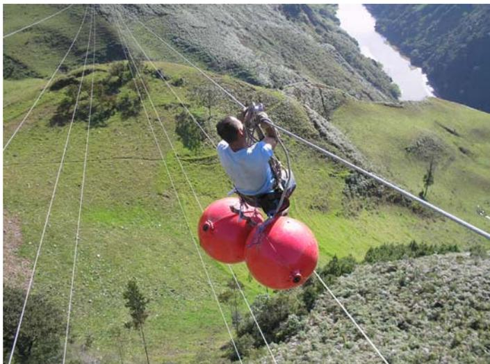
**Figura 2.22.** Colocación de balizas en la línea de alta tensión en el tramo Santo Domingo-Quevedo
