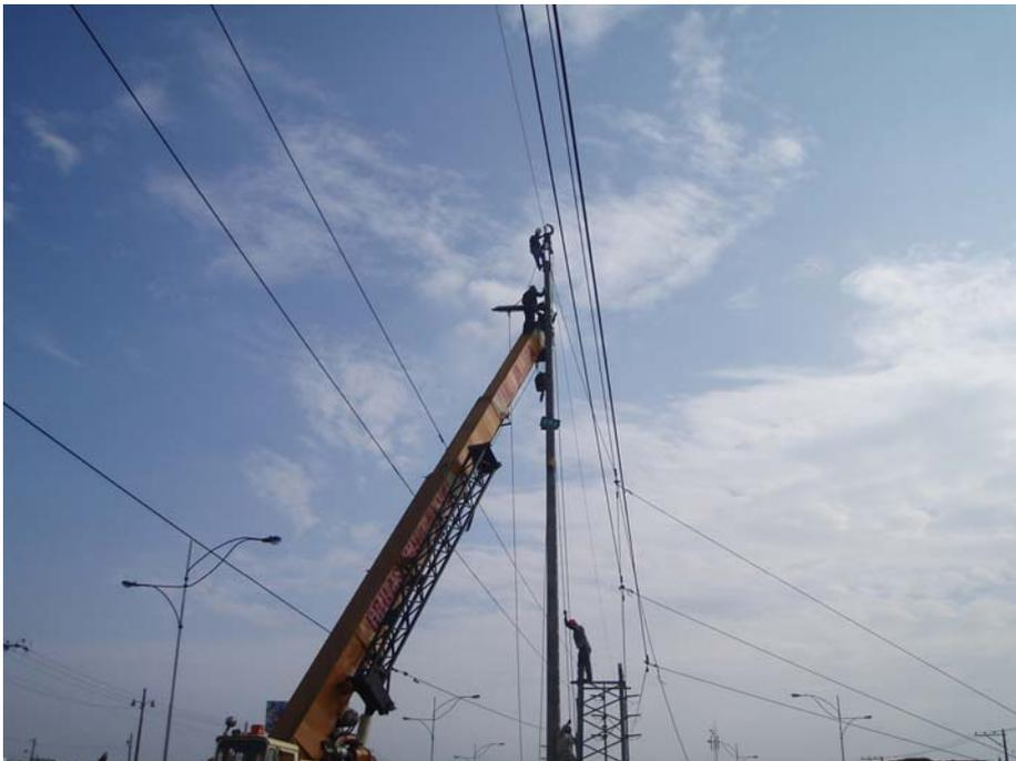
**Figura 2.13. Puesta de pilones en la línea de alta tensión**
