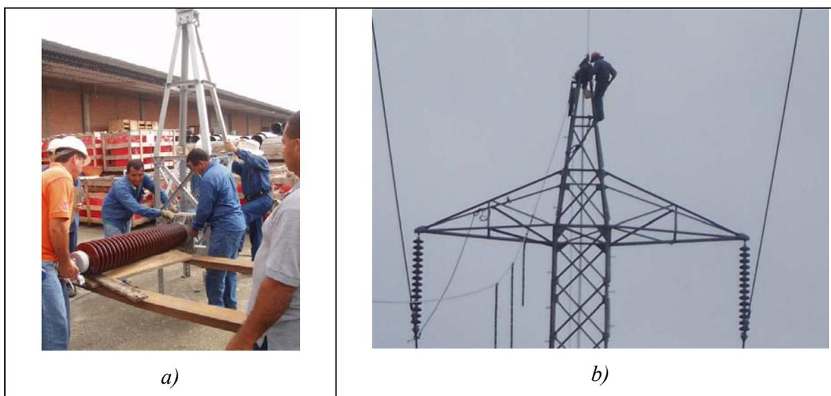
**Figura 2.16. a) Transportando un aisladores. b) Aislador colocados en torres de alta tensión**
