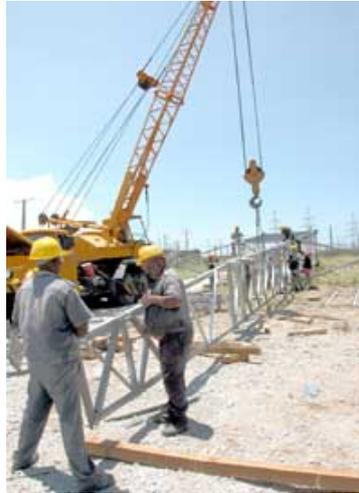
**Figura 2.4. Proceso en que levanta una torre de alta tensión**
