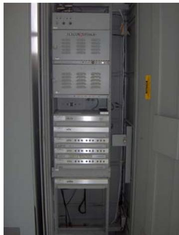
**Figura 1.4. Equipo de Power Line Communication analógico marca General Electric**
