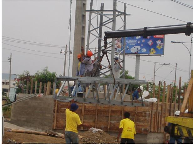
**Figura 2.14. Fundición de una torre en la línea Quevedo-Policentro**
