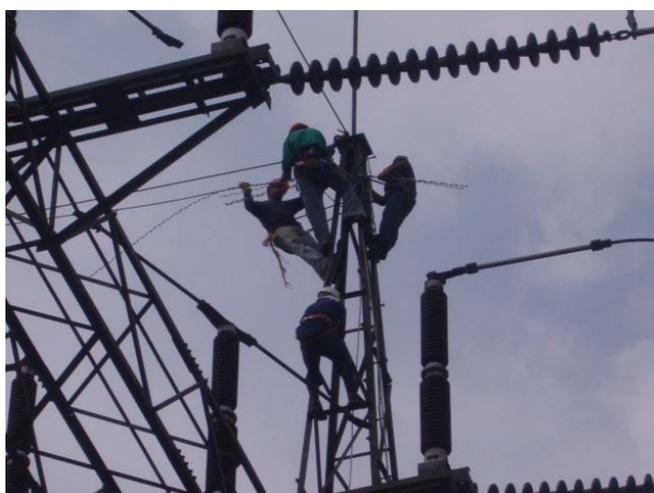
**Figura 4.10. Mantenimiento de líneas de alta tensión.**
