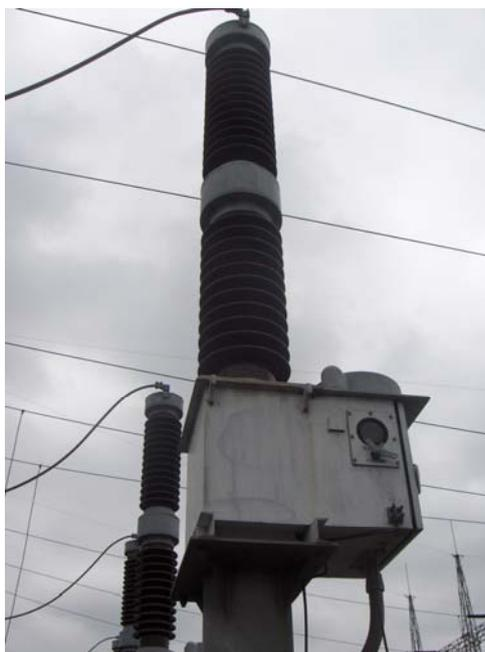
**Figura 1.13. Equipo de capacitares de acoplamiento en la subestación de Quevedo**
