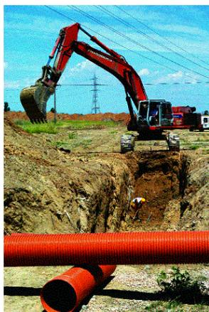
Figura 2.12. Preparación del suelo para la instalación de una torre de alta tensión
