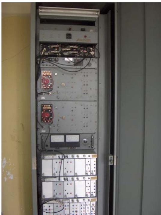
**Figura 1.20. Equipo de teleprotección en la subestación de Quevedo marca General Electric**
