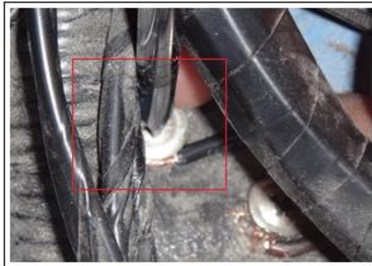
Figura 3.19 Conexión de masa del PLC
