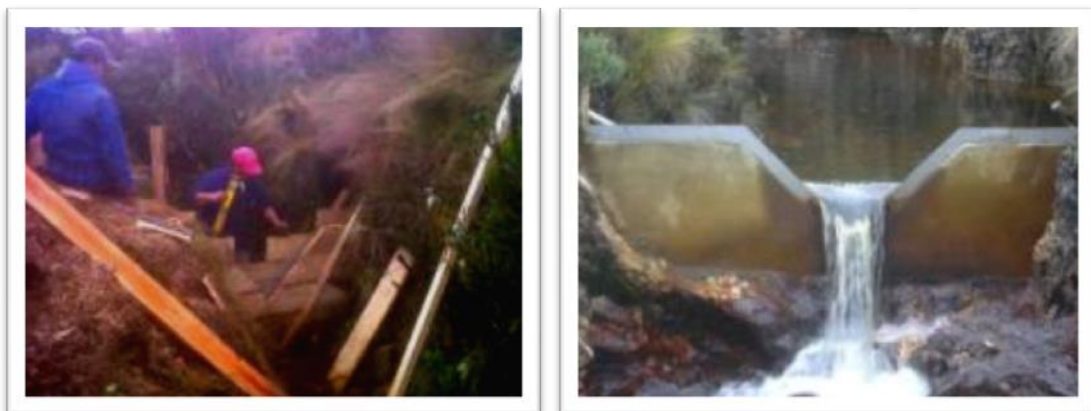
Figura 89. Construcción de vertederos
