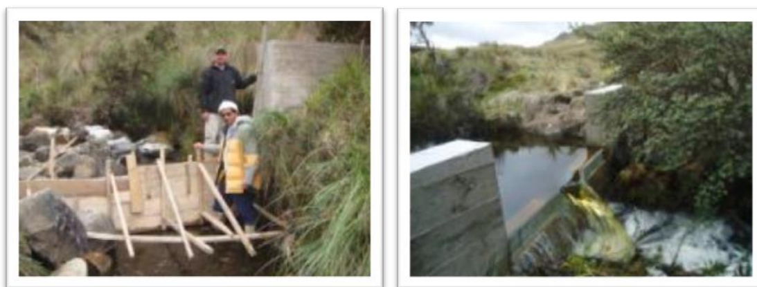
Figura 87. Construcción de vertederos
