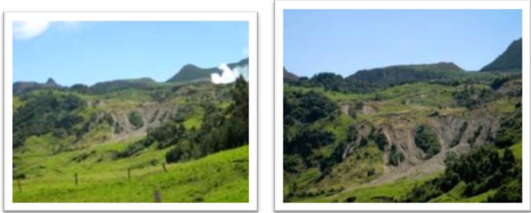
Figura 62. Zona de deslizamiento
