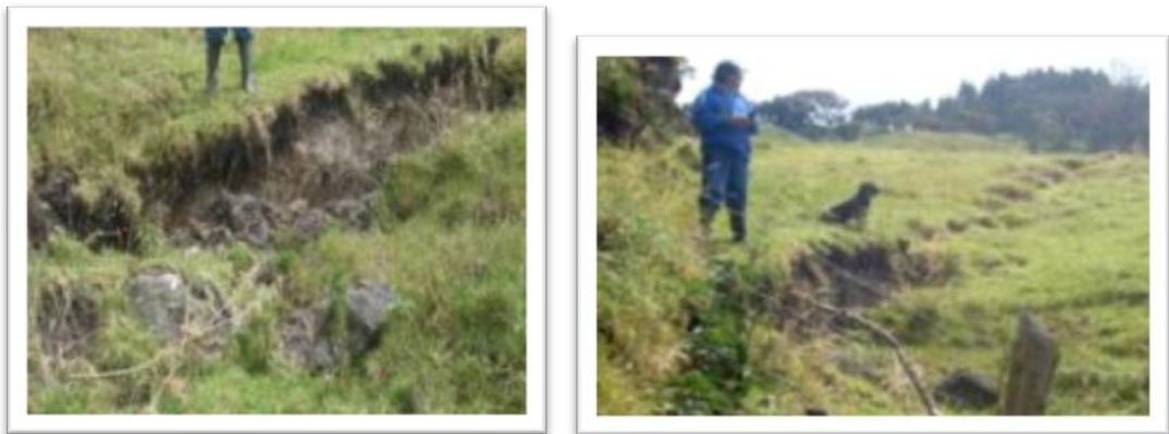
Figura 63. Grieta de deslizamiento superior
