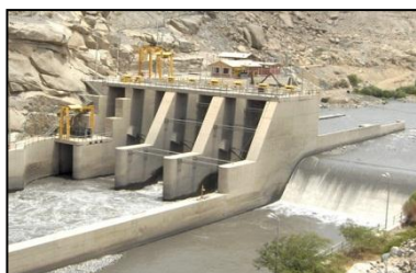
Compuertas de la Bocatoma "Desarenador". Fuente: Mora, Darwin, Estudio para la Automatización de las compuertas de la Bocatoma para la Central Hidrosibimbe, 2007
