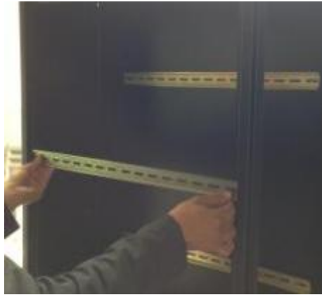
Grafica 8: Instalación Rieles
