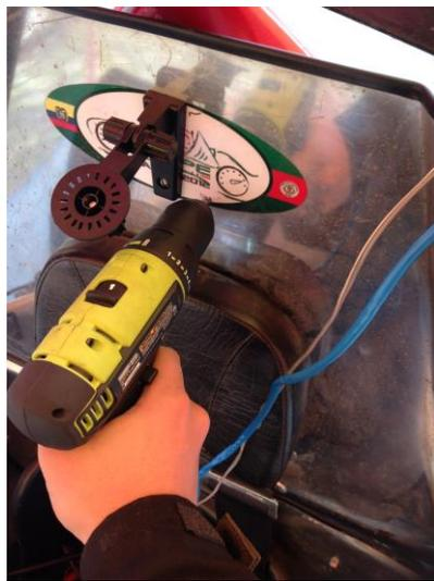
**Figura 3. 28 Montaje de la base para la cámara de video.**
