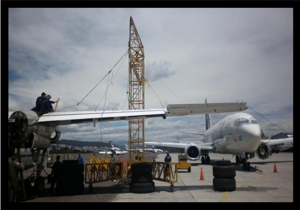
**Figura B7:** Retiro de los soportes para la estabilidad del ala.
