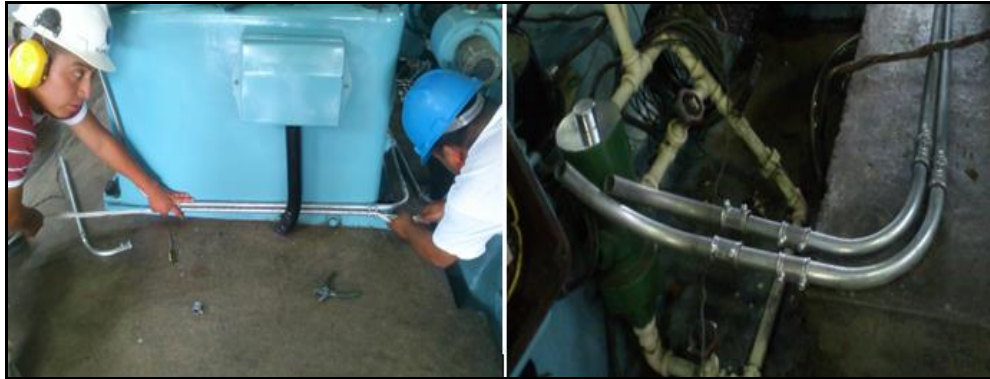
Figura 2. 7: Instalación de la tubería para el tendido del cable de comunicación
