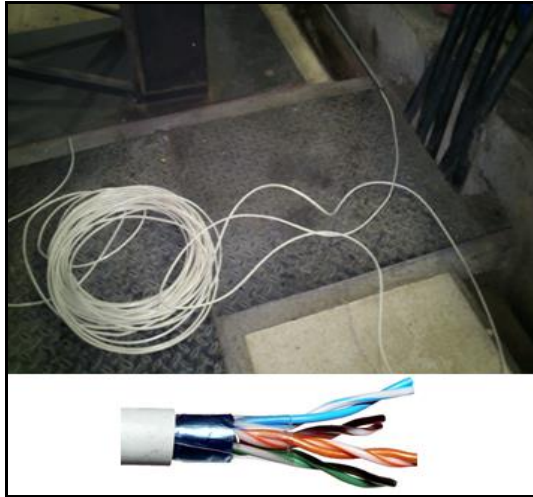
Figura 2. 8: Cable de comunicación par trenzado
