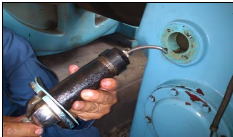
Figura 2. 3: Instalación del Sensor PT-100 en la turbina del generador
