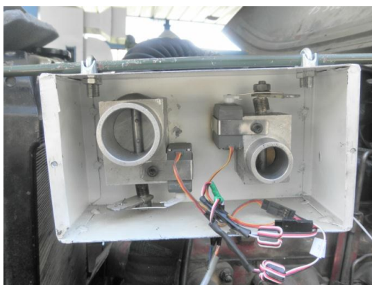
Fig. 145 Instalación de válvulas de control
