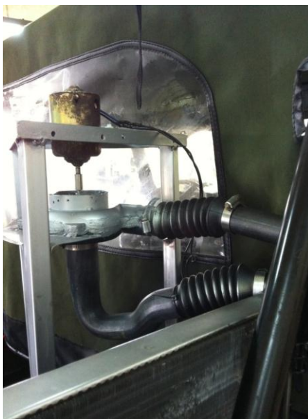
Fig. 148 Instalación del motor de succión.
