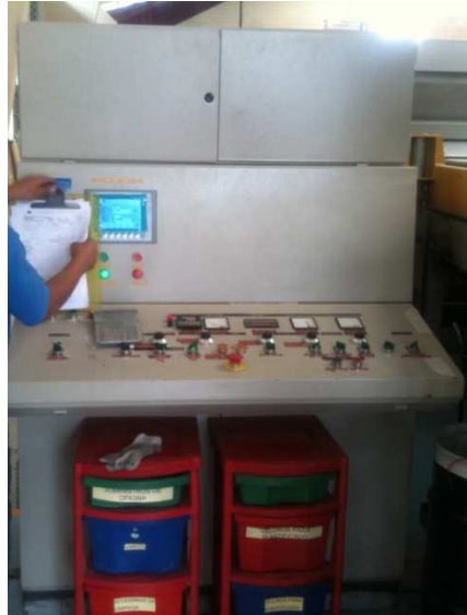
Figura 4.13. Instalación del Gabinete de Control
