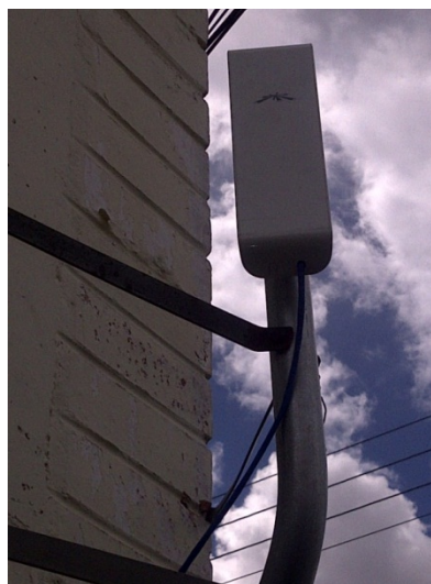
Figura 4.9: Instalación equipo CPE WiFi.
