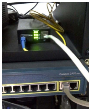
Figura 4.14: Pruebas de funcionamiento del equipo WDM.
