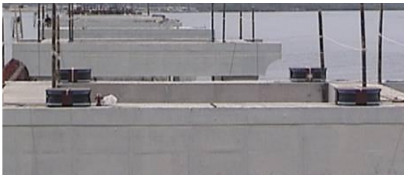
Figura 6 Instalación de Aisladores de Sísmicos
