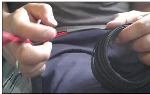
Figura 5.58: Introducción de los cables dentro de la protección termocontraíble.
