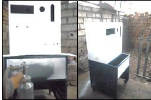
Figura 6.11: Aplicación de PRIME y pintura de la estructura metálica.
