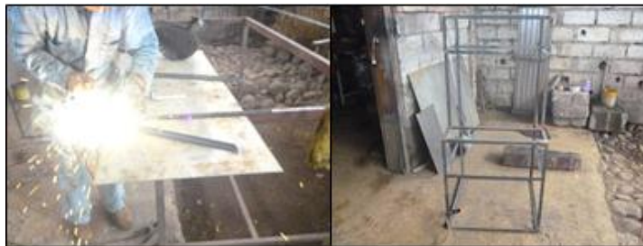
Figura 6.9: Construcción de la estructura metálica. Fuente: Investigadores.
