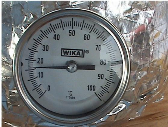
**Figura 6.17** Medidor de temperatura interna del digestor
