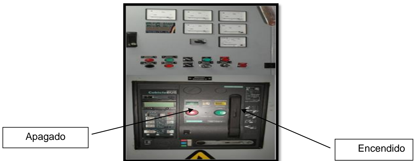
Figura 3-23 Vista frontal del tablero del generador#2 y generador#1
