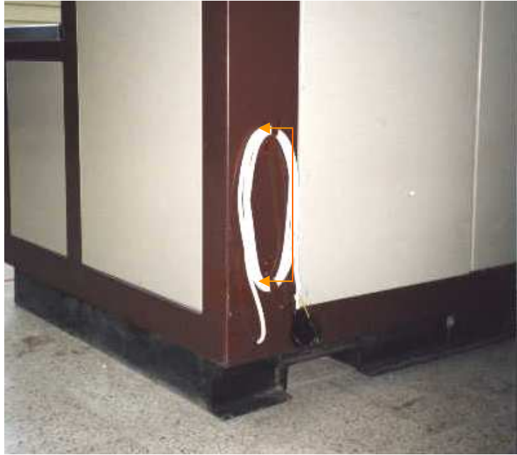
Figura 3.9. Soportes del cable eléctrico
