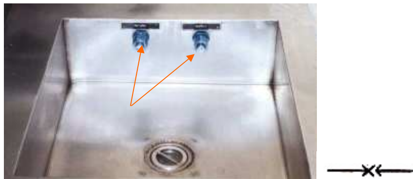
Figura 1.24. Puertos de conexión para comprobaciones
