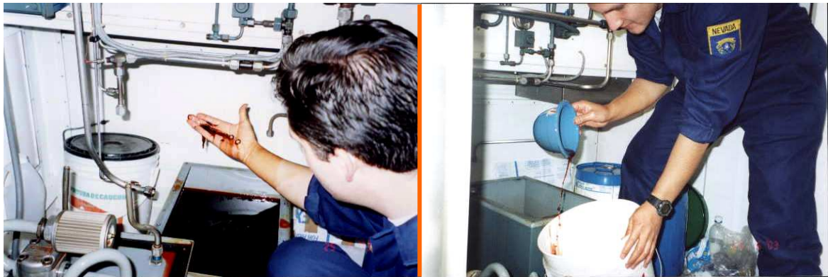
Figura 3.3. Cambio de líquido hidráulico
