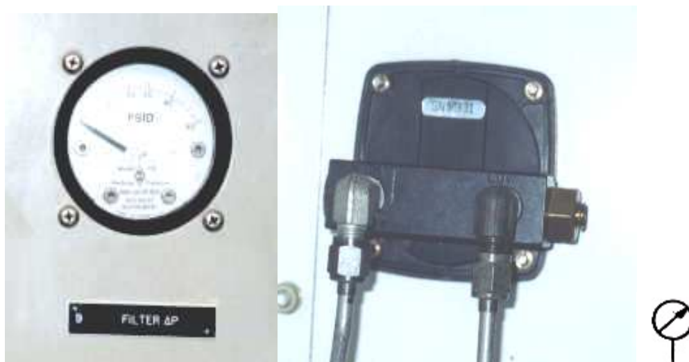
Figura 1.12. Manómetro de presión diferencial (lado anterior y posterior)
