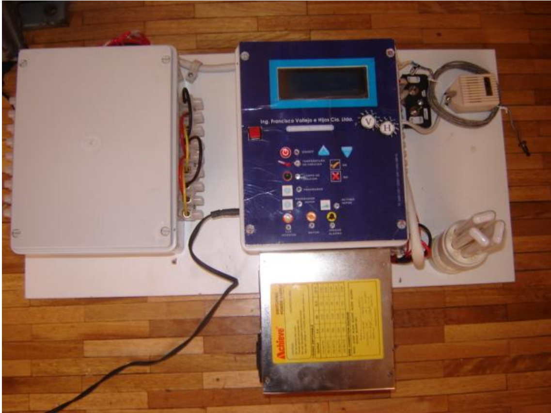
Imagen 24 INSTALACION SISTEMA AUTOMATIZACION
