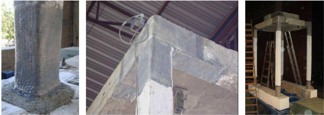
Figura 10: Refuerzo del pórtico con fibra de vidrio Fuente: (Palazzo & Martín, 2012)
