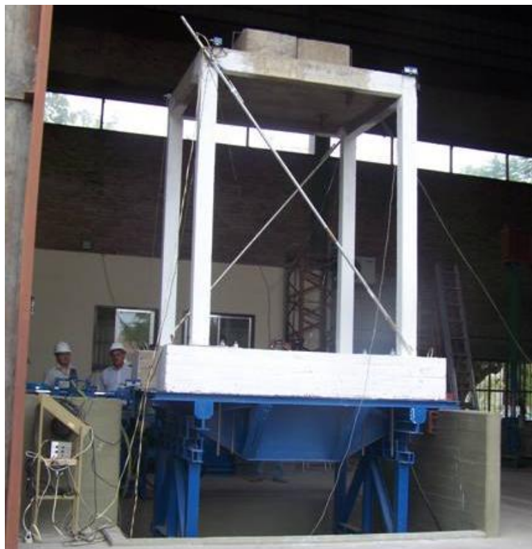
Figura 8: Pórtico antes de reforzar Fuente: (Palazzo & Martín, 2012)
