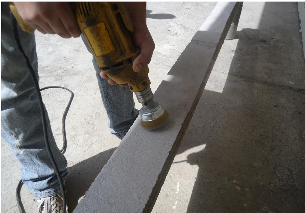
Figura 27: Limpieza de la superficie Fuente: Elaborado por: Cevallos, Diego
