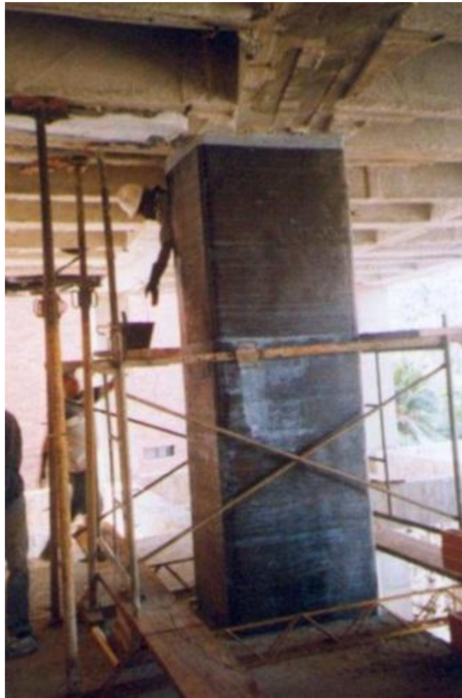
Figura 7: Colocación de SikaWrap 300C Fuente: (Rendón & García, 2013)
