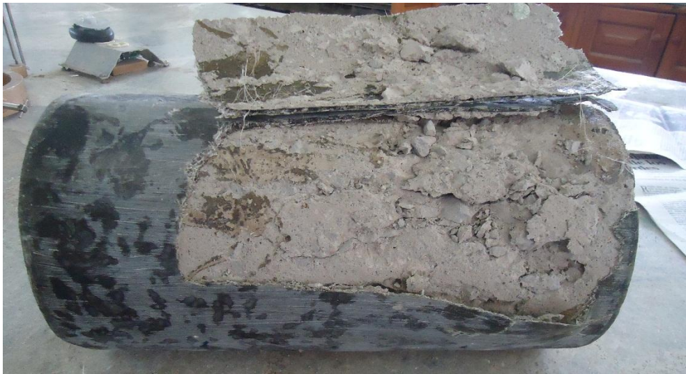
Figura 65: Plano de falla y grietas en hormigón confinado con dos capas de fibra de vidrio tradicional
