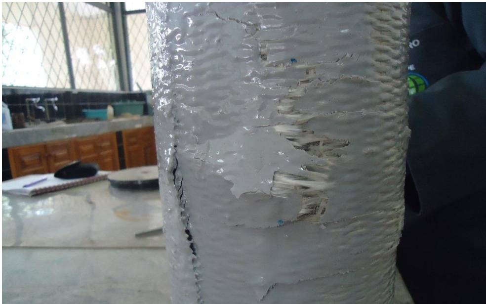
Figura 59: Falla del cilindro con FRP Fuente: Elaborado por: Cevallos, Diego
