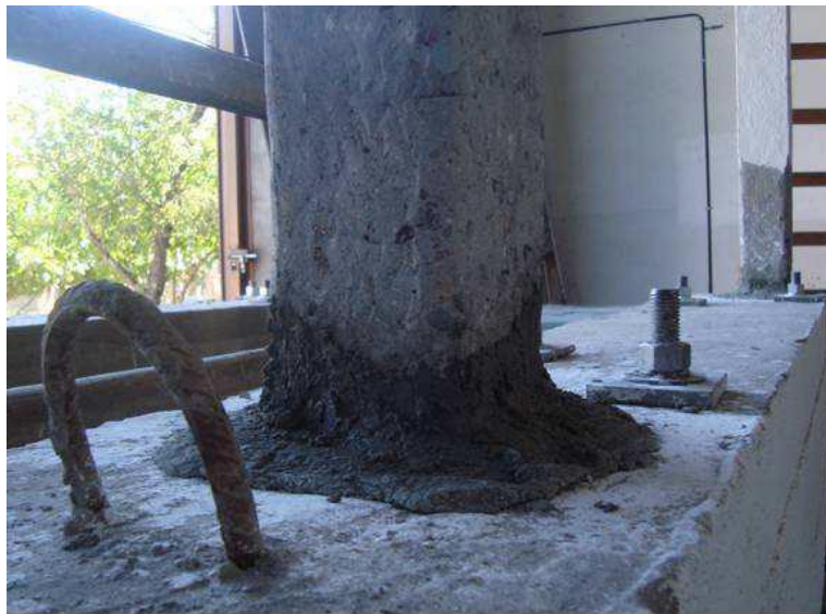
Figura 9: Rehabilitación de las bases de las columnas del pórtico
