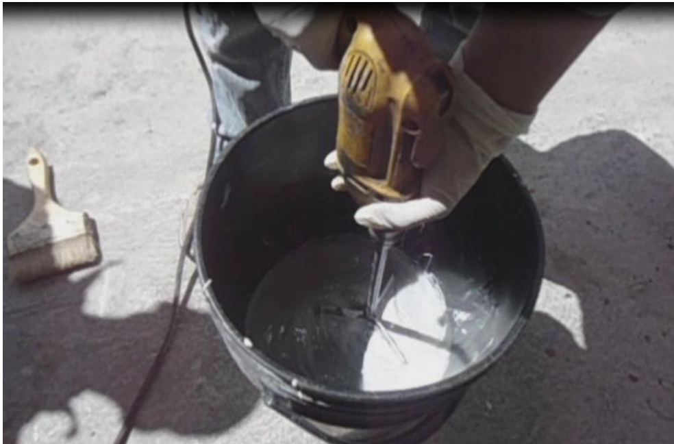
Figura 32: Mezcla de componentes A y B Fuente: Elaborado por: Cevallos, Diego
