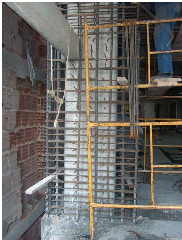
Figura 46: Encamisado de columnas Fuente: (Rendón & García, 2013)
