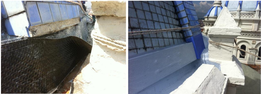
Figura 16: Colocación y presentación final del reforzamiento Fuente: (Rendón & García, 2013)
