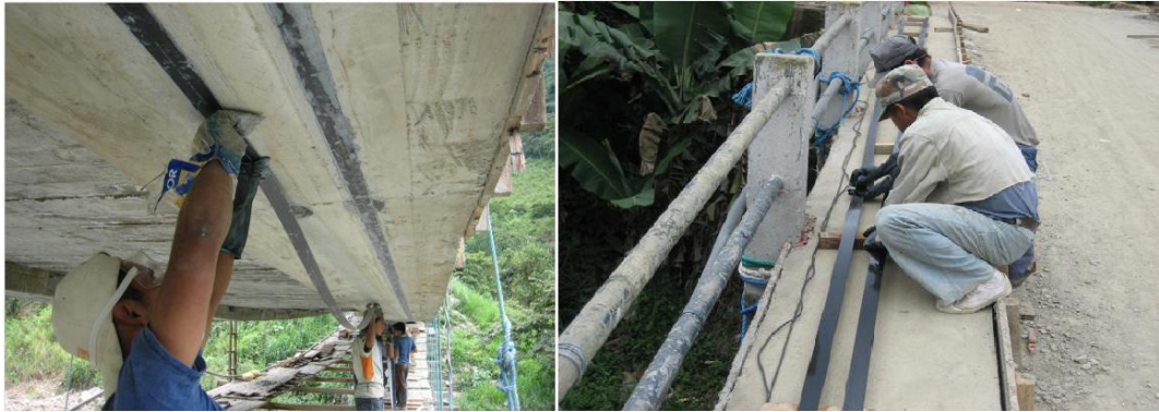
Figura 20: Colocación de platinas Sika Carbodur Fuente: (Rendón & García, 2013)
