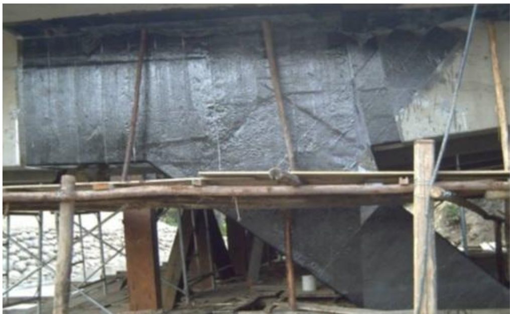
Figura 23: Colocación de fibra de carbono Fuente: (Rendón & García, 2013)
