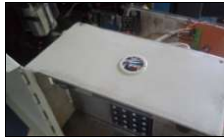
Fuente: Autor Figura 7: Instalación del sistema de encendido
