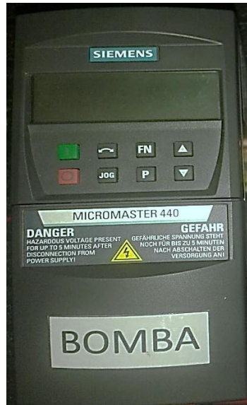
Figura 3.5: Variador de frecuencia del proceso caudal.
