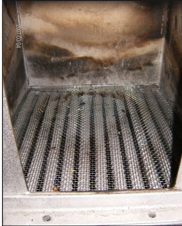
Fotografía 1. Cámara de combustión
