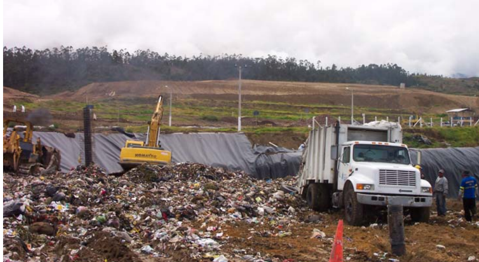
Figura. 6.5. Recolector descargando Residuos en el Relleno Sanitario
