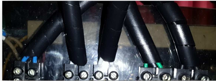
Figura 99 Organización del cableado mediante espiral 2
