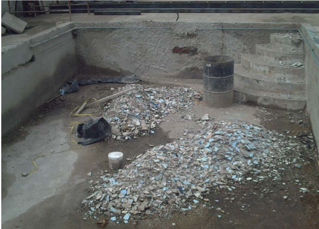
Foto3. Preparación del vaso de la piscina
