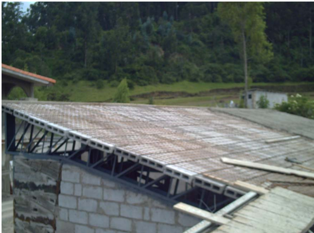
Foto4. Construcción de la terraza de la infraestructura.
