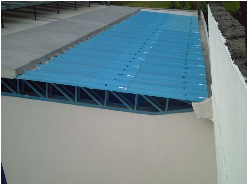
Foto14. Colocación de los translucidos cubiertas.
