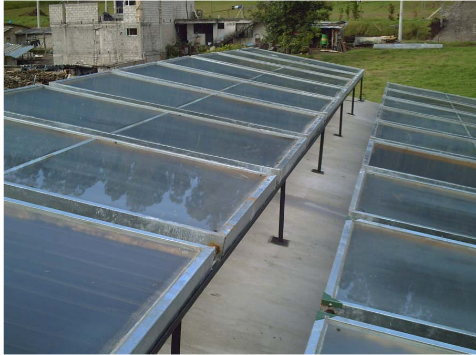
Foto11. Colocación de los colectores sobre estructura base y su instalación hidráulica
