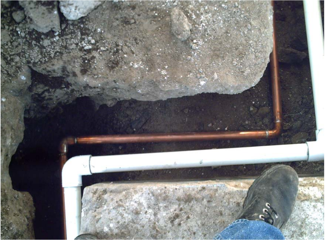
Foto7. Instalación tuberías del circuito de climatización y recirculación
