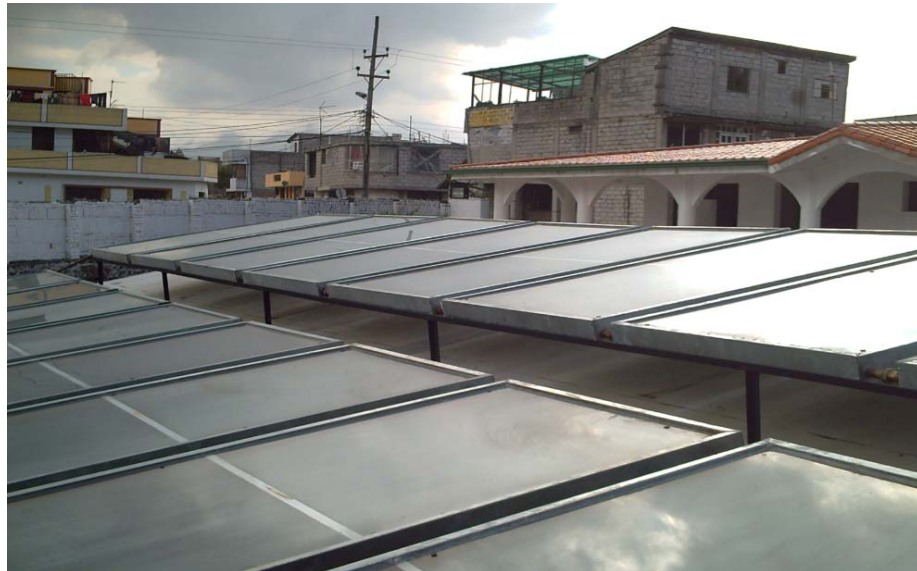
Figura 6.5.3 Montaje e instalación de los colectores solares.
