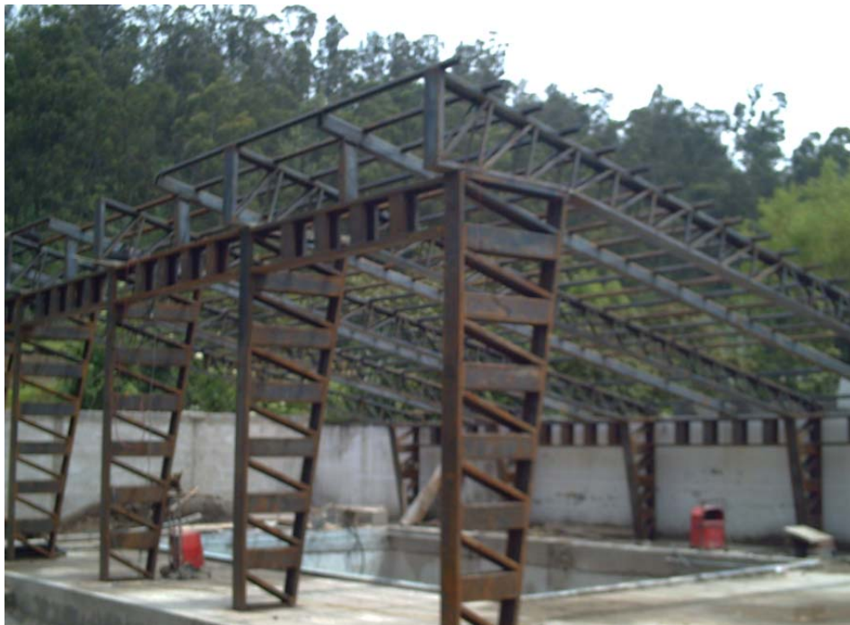
Foto2. Construcción de la estructura metálica cubierta
