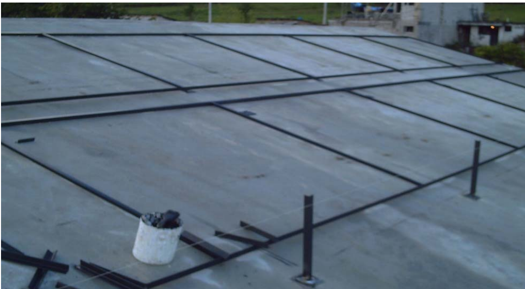
Figura 6.7.2 Elaboración y soldada de soportes (patas).
