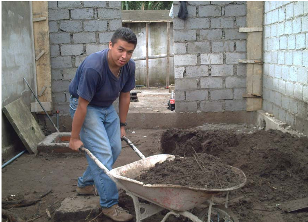
Foto6. Construcción de la sala de maquinas en el subsuelo (Sr. Dávalos).
