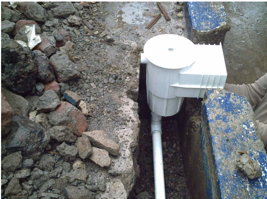
Foto8. Colocación del desnatador o skimmer de la piscina.
