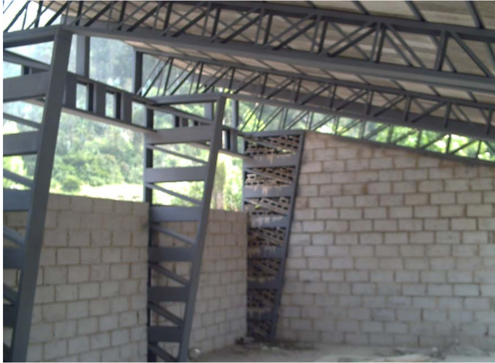
Foto5. Construcción de paredes de encerramiento.
