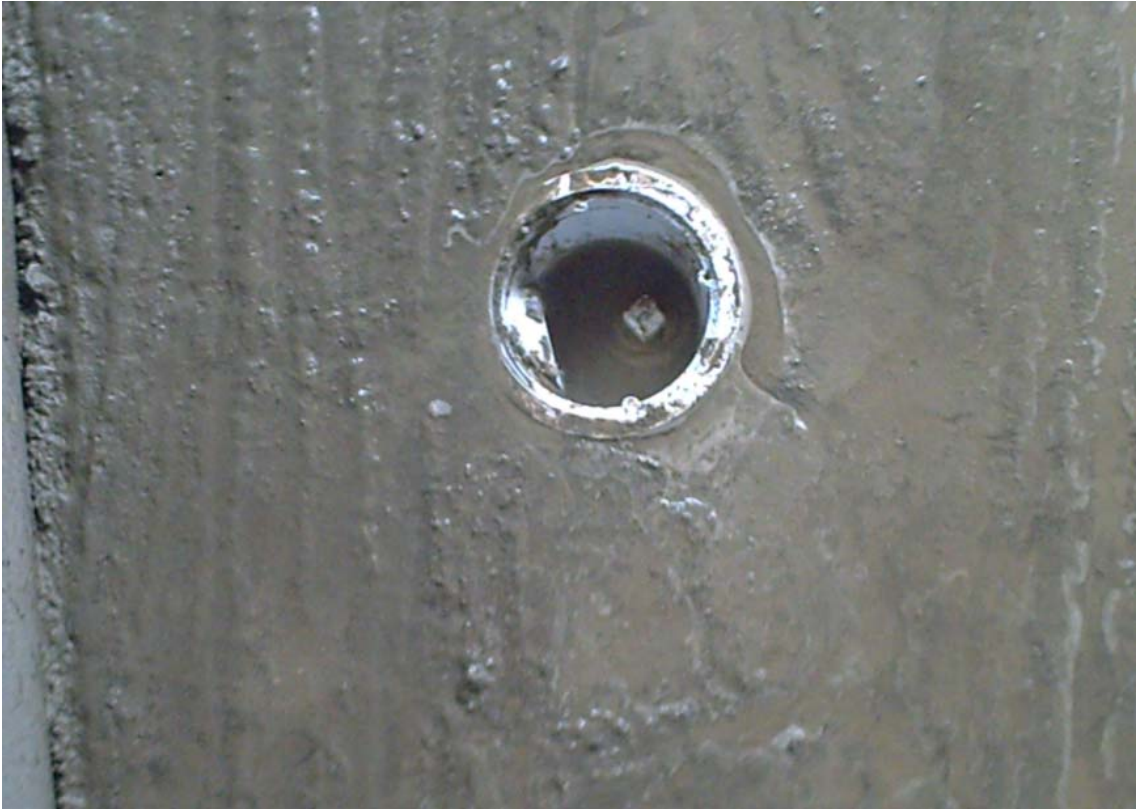
Foto9. Colocación de la rejilla del fondo de la piscina.
