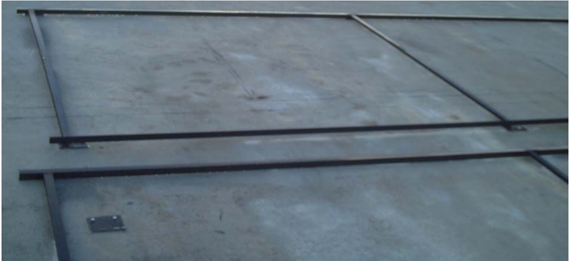
Figura 6.7.1 Elaboración del marco estructural y sujeción de placas base.
