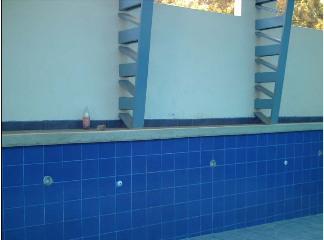
Foto13. Acabado final de las paredes, y piscina.
