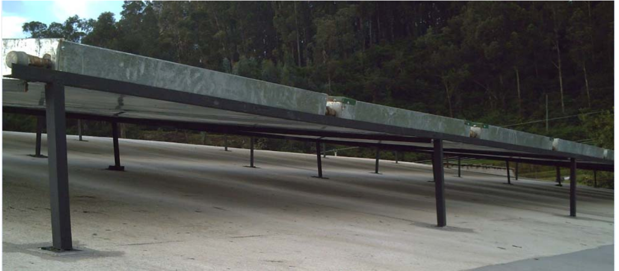
Figura 6.7.3 Soldada del marco, montaje y soldada de los transversales e instalación de los colectores solares.
