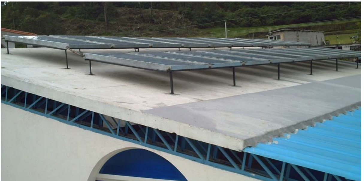
Figura 6.7.4 Esquema final de los colectores sobre el soporte metálico.
