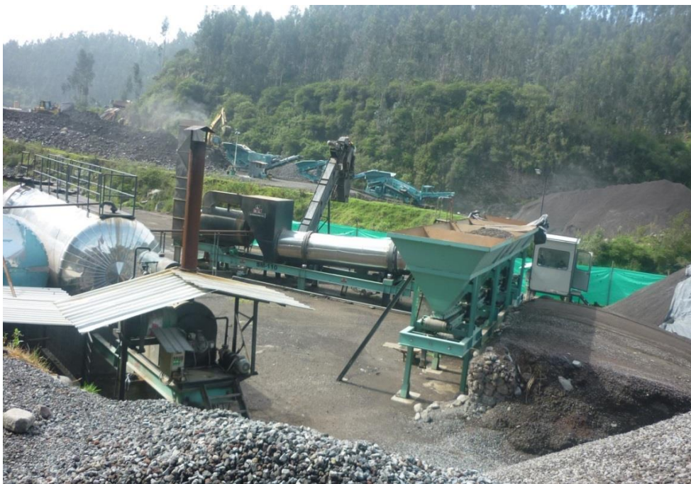
Figura. 35: Planta de Mezcla Asfáltica de la Constructora Naranjo-López (Sitio de muestreo)
