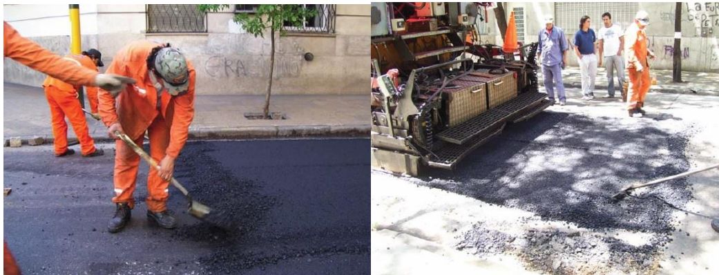
Figura. 31: Colocación en Argentina de la mezcla asfáltica tibia
