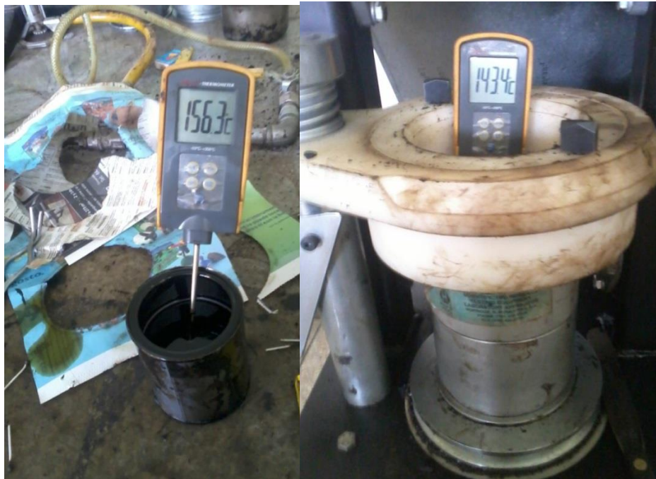
Figura. 82: En la de la izquierda se evidencia la temperatura del asfalto a 156.3 °C listo para la mezcla, en la derecha se ve la temperatura de la mezcla lista para para la compactación a 143.4 °C.
