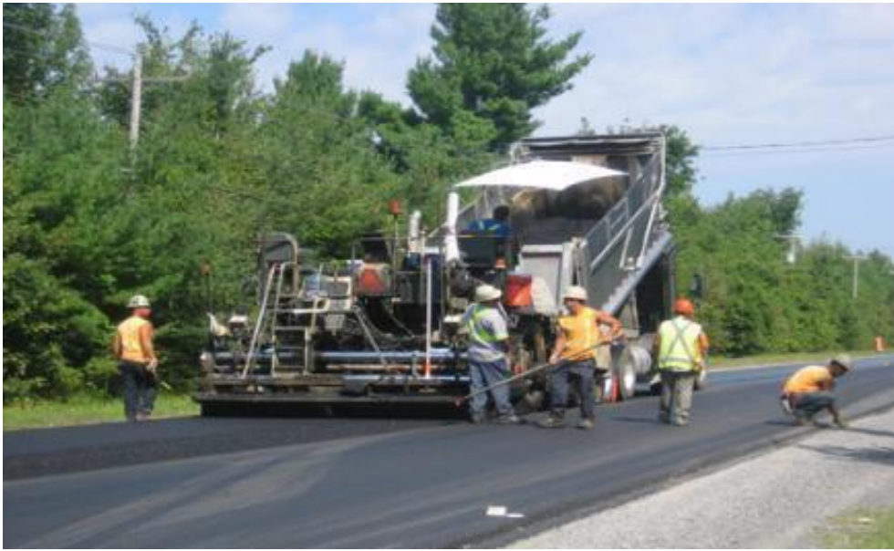
Figura. 18: Instalación de mezcla tibia con Evotherm 3G
