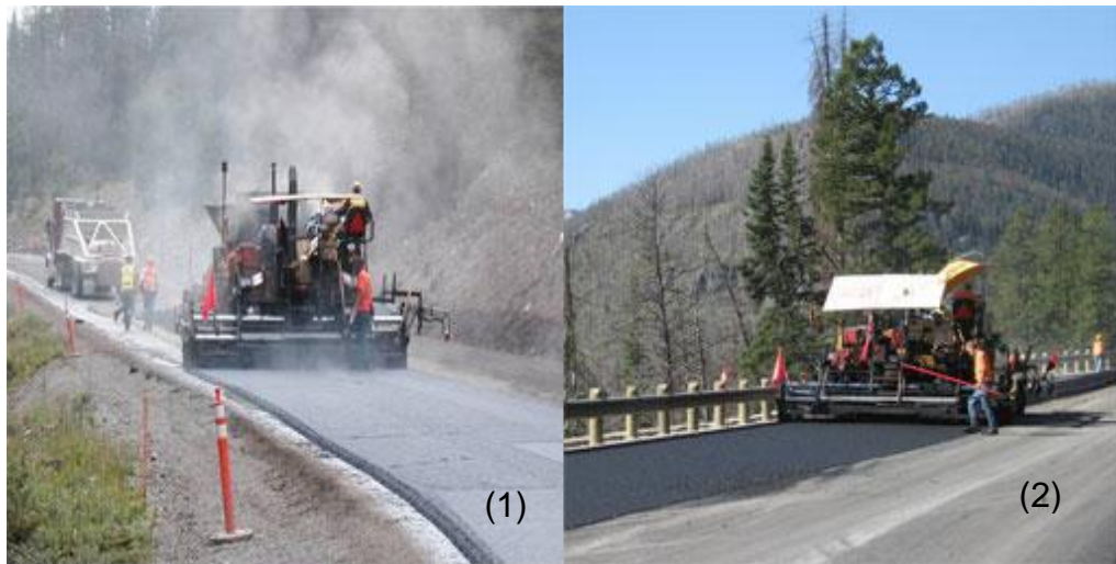
Figura. 2: Colocación de tipos de mezclas asfálticas.
