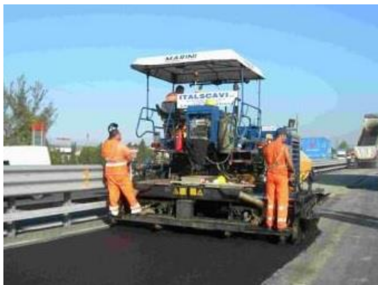
Figura. 24: Ausencia de humos en la colocación del WAM
