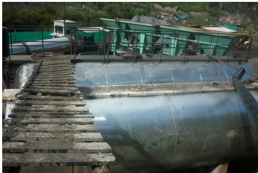
Figura. 36: Tanque de Almacenamiento de Asfalto
