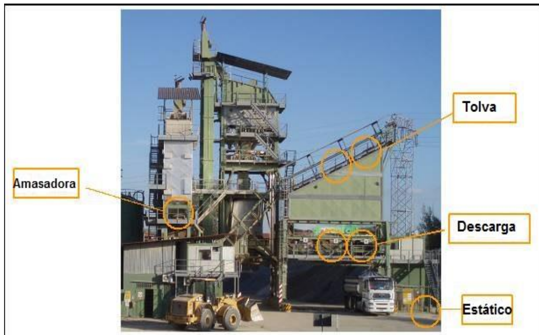
Figura. 22: Posiciones de la toma de muestras en la planta
