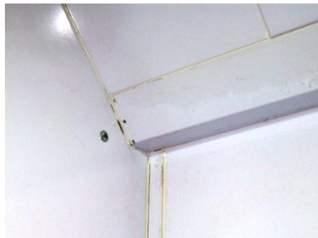
Figura 2.12 Sellado de Uniones ( Vista interna de una esquina de la cabina-horno )
