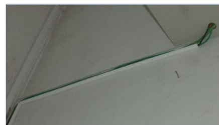
Fig. 4. Tendido del cable Ethernet con la alimentación del PLC.
