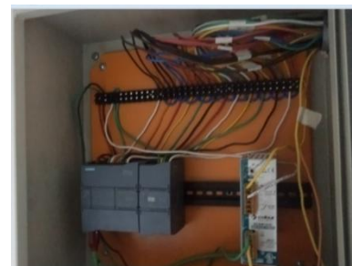
Fig. 3. Se monta la caja para conectar con el cableado de las máquinas.
