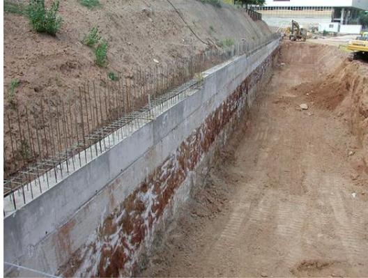
**Foto N°2.** Muro de contención
