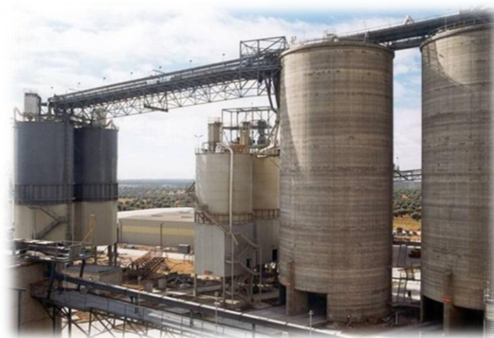
Figura 37: Silos de almacenamiento del clinker
