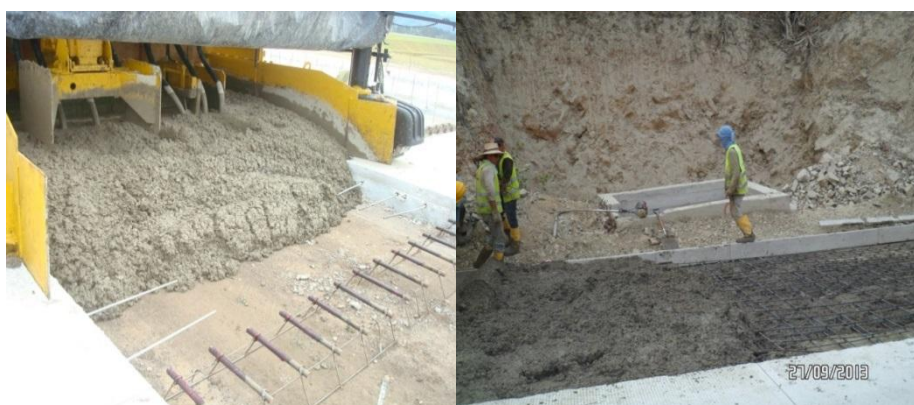
Figura 68: Uso de regla vibratoria Fuente: FOTOS PLANTA HORMIGONERA
