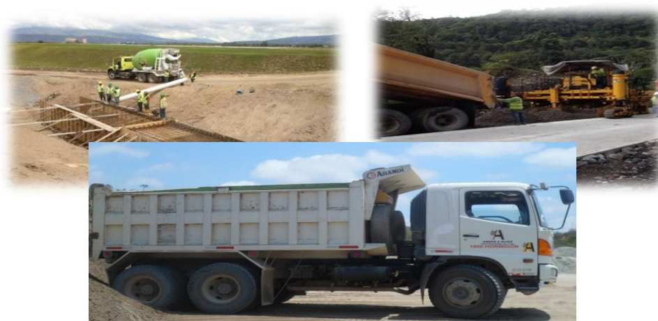
Figura 67: Mezclado en planta y entrega con camión mezclador FUENTE: FOTOS DE PLANTA HORMIGONERA HORMICONCRETOS
