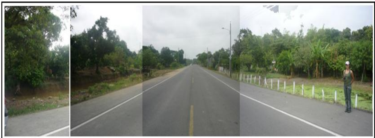
Foto. C.12. Área de afectación de las inundaciones, área de desborde del cauce.
