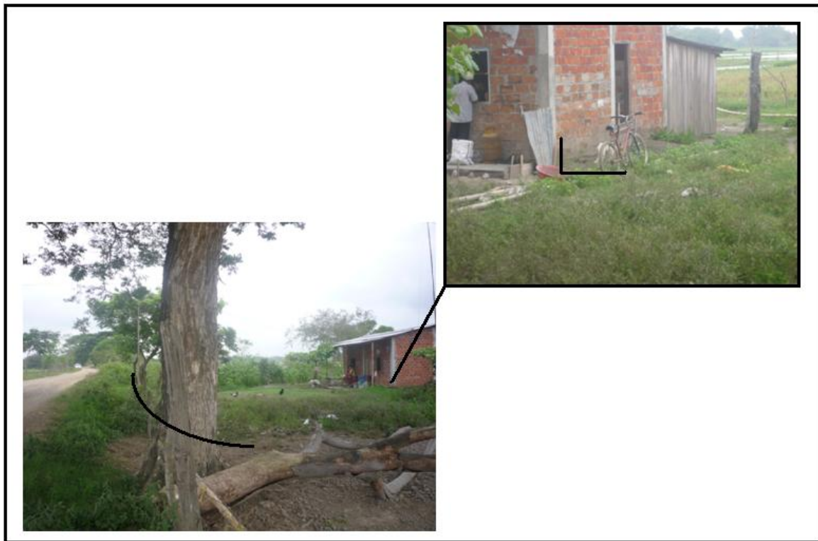
Foto. C.20. Viviendas afectadas en las inundaciones.
