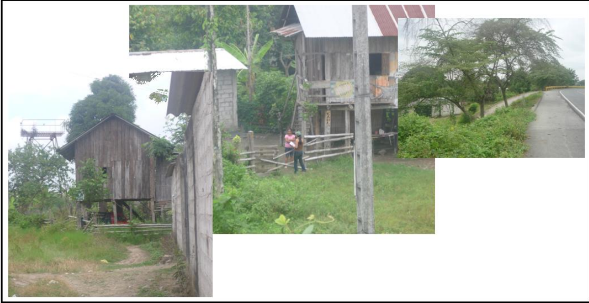
Foto. C.17. Viviendas localizadas en la llanura de inundación.
