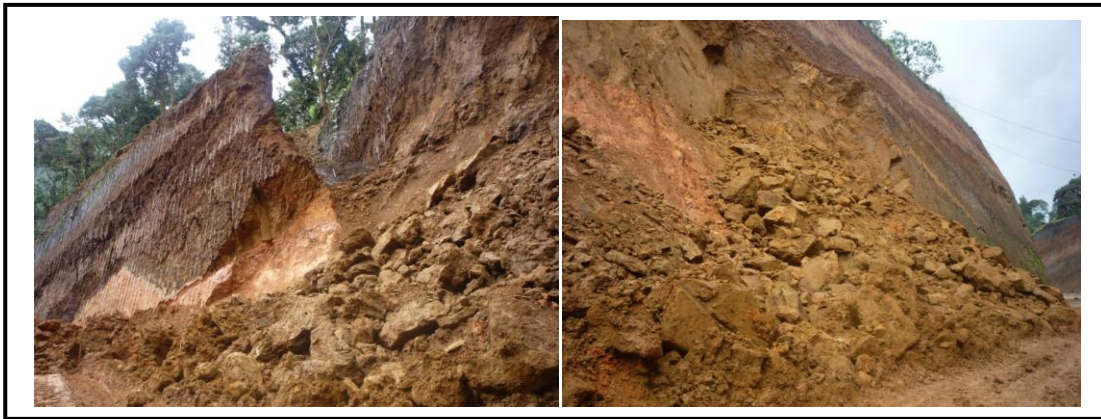
Foto. C.1. Movimiento en masa por fracturamiento y pendientes fuertes.
