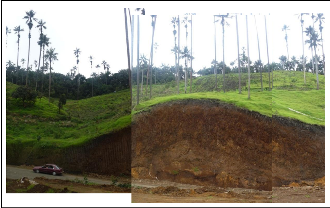
Foto. C.9. Vegetación y talud.
