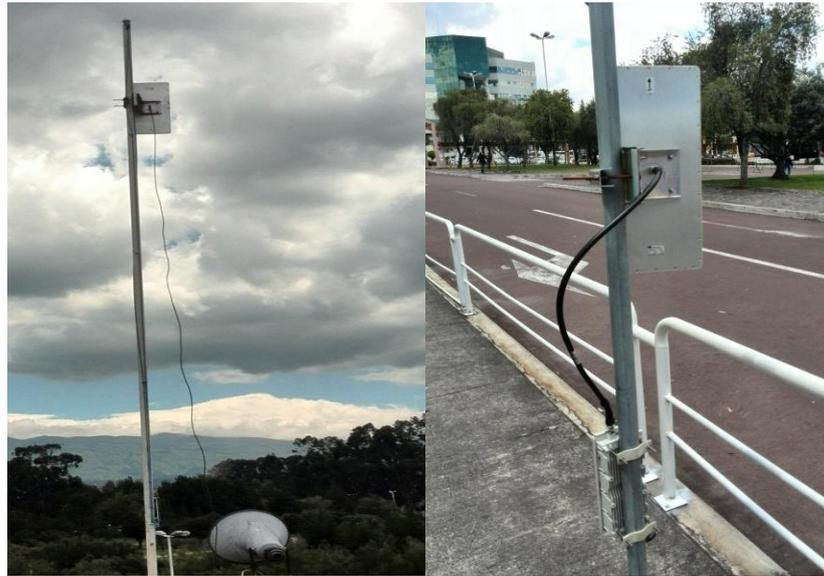
**Figura. 78. Antenas Alvarion WIMAX, del enlace.**
