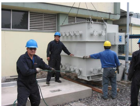
Fotografías 4.1: Montaje del transformador de potencia.
