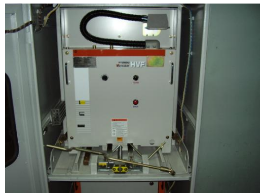
Fotografía 3.2: Tablero de alta tensión (para interconexión con las barras de 6600 V, y el transformador de elevación de potencia).
