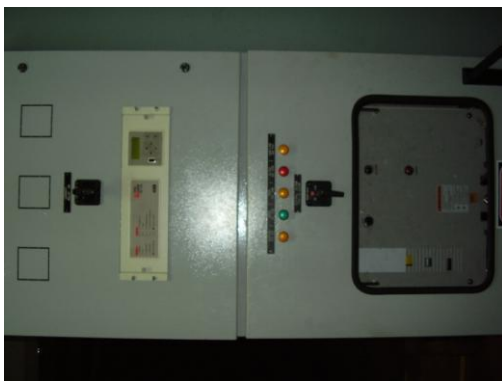
Fotografía 3.2: Tablero de alta tensión (para interconexión con las barras de 6600 V, y el transformador de elevación de potencia).
