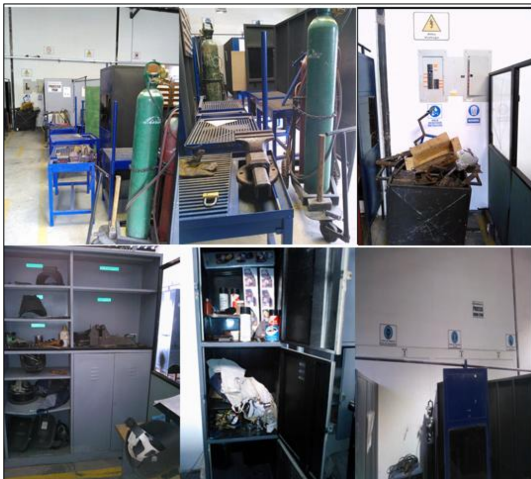
Figura 3. 3: Deterioro del Laboratorio.
