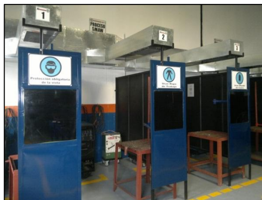
Figura 4. 42: Señalización actual de los habitáculos de Soldadura
