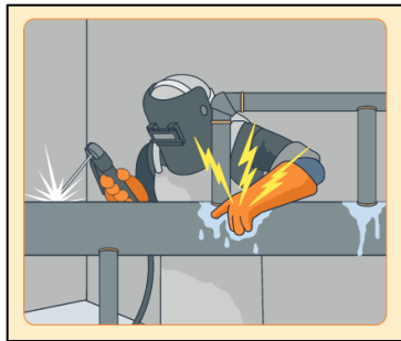
Figura 4. 50: Riesgo de accidente de soldadura producido por humedad
