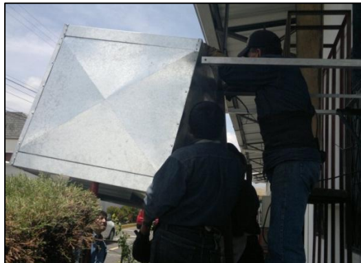
Figura 4. 30: Instalación de manejadoras de extracción
