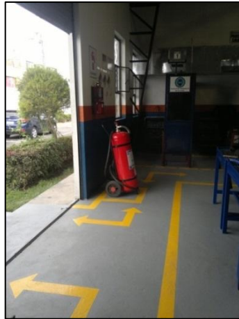
Figura 4. 36: Demarcado y pintado de pisos
