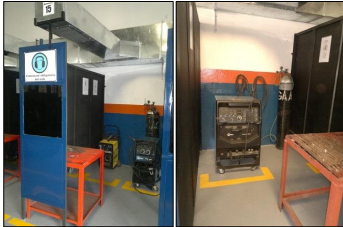
Figura 4. 47: Habitación y suelda eléctrica MIG - MAG
