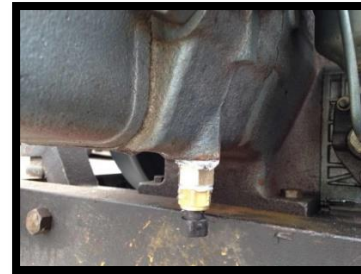
Figura 16: Instalación del sensor de temperatura agua motor
