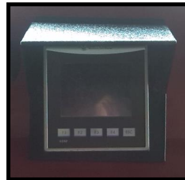
Figura 17: Instalación de la pantalla del tablero
