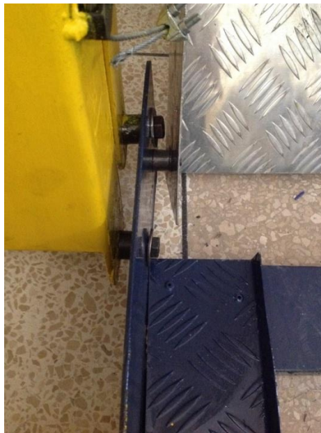
Figura 119. Implementación de bocines metálicos en la plataforma
