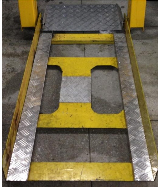
Figura 15. Rieles para mejorar la sujeción de la silla de ruedas
