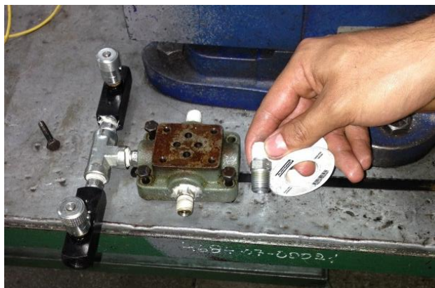
Figura 47. Aplicación de teflón y sellante para evitar fugas
