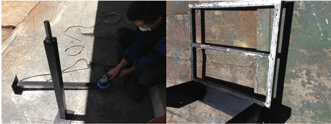
Figura 48. Remoción de óxido y de la pintura anterior
