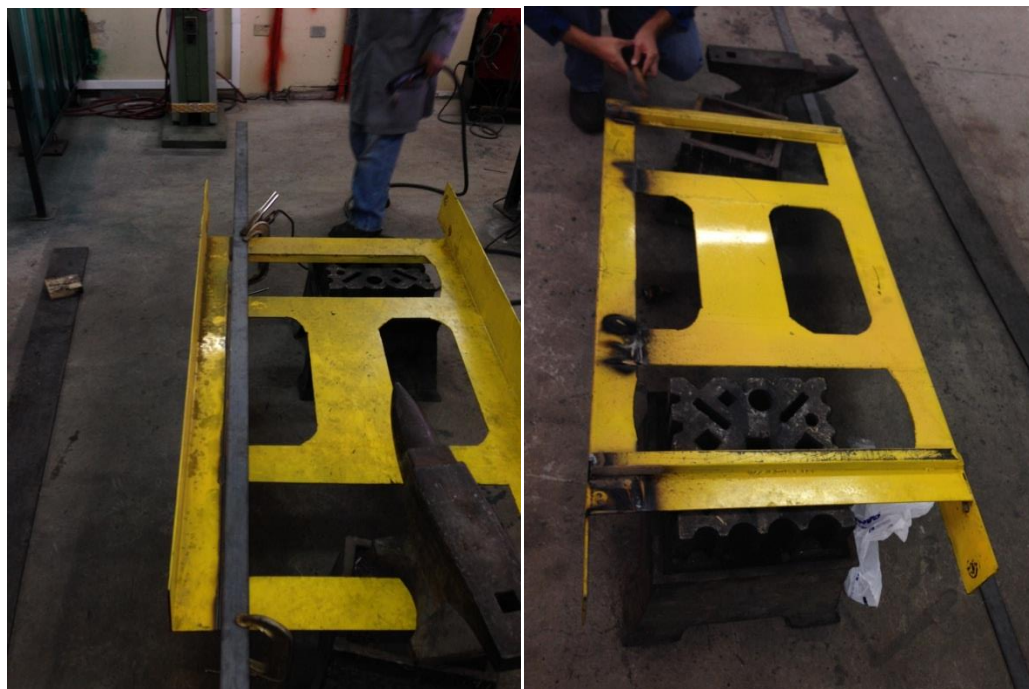
Figura 50. Corte y soldada de la plataforma
