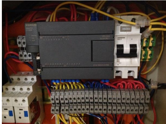
Figura 132. Implementación del PLC
