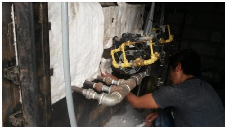
**Figura 80. Aislamiento térmico en la zona de quemadores**
