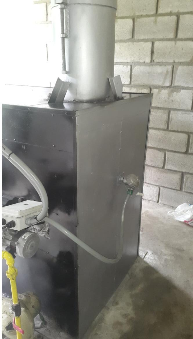
**Figura 88. Terminado posterior y termocupla tipo K**
