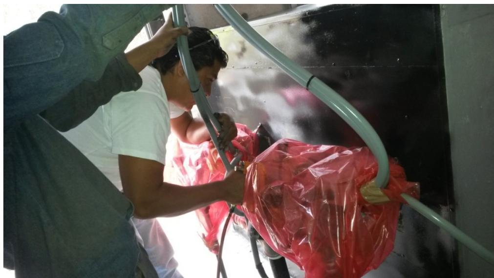
**Figura 82. Aplicación de pintura anticorrosiva**
