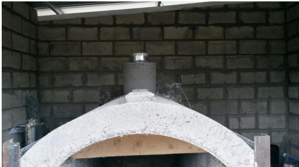
**Figura 76. Cúpula de refractario y base de chimenea**
