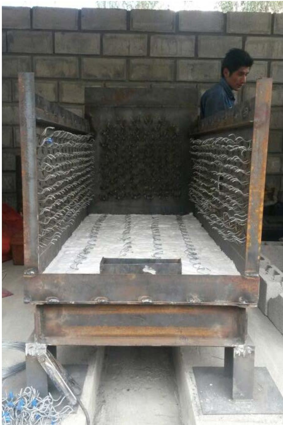
**Figura 73. Estructura metálica lista para fundir el cemento refractario**
