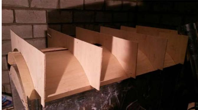
**Figura 7. Encofrado para cúpula**
