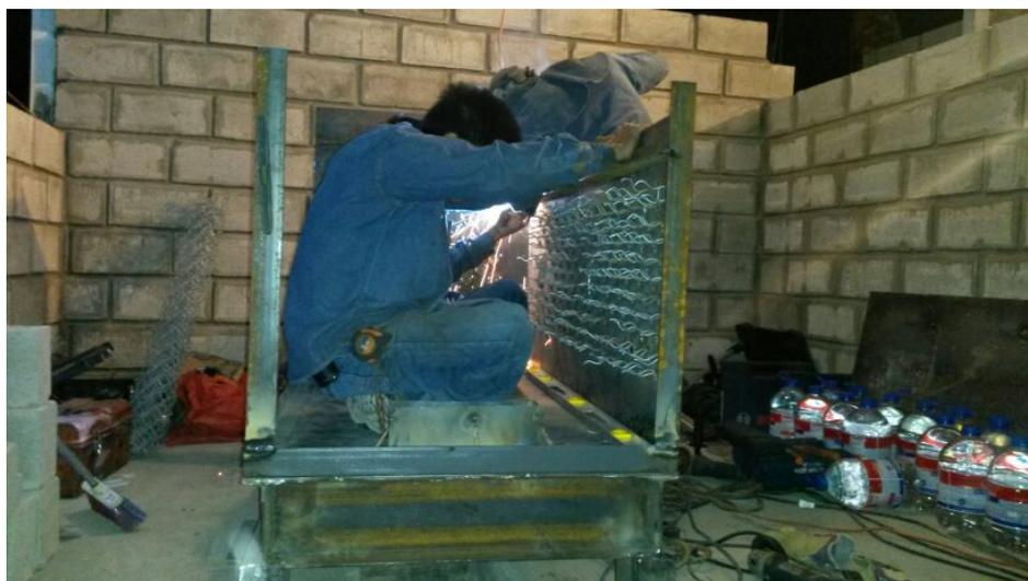
**Figura 72. Paredes metálicas para soporte de refractario**
