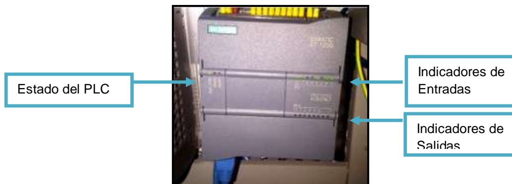
FIGURA 4.4.Verificación de estado del PLC.
