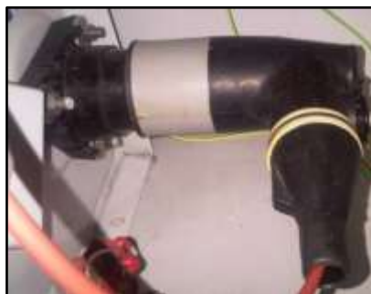
FIGURA 3.21. Bushing insert de aislamiento
