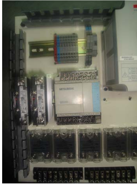
Figura 5.5. Sujeción en riel DIN 35 mm del PLC
