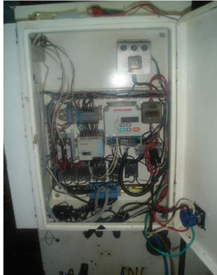
Figura 5.12. Montaje del sistema de control en el armario
