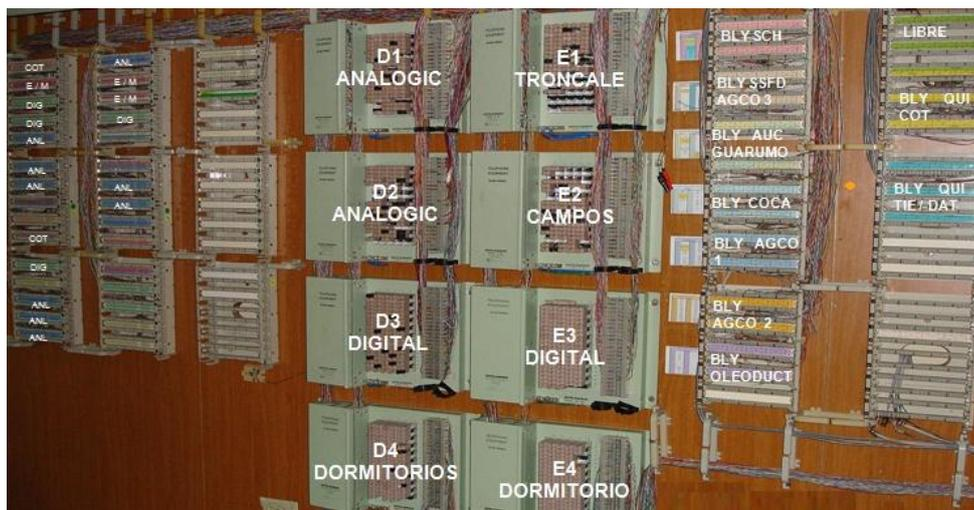
**Figura. 3.3. Sistema Conexiones al PBX.**
