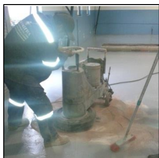
Figura No. 13: Alisado del piso Autores: Ayala A. Mogro A.
