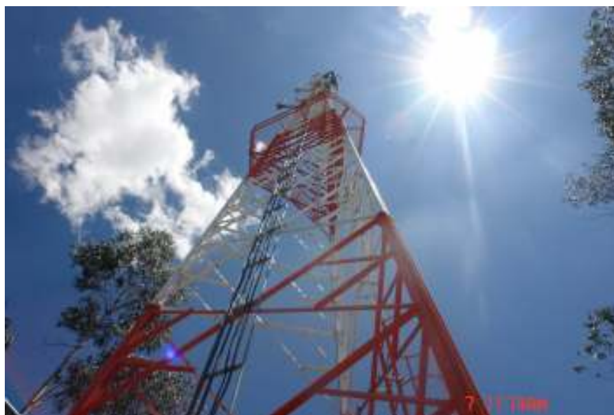
Figura. 6.9. Torre Autosoportada
