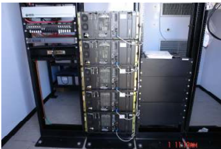
Figura. 6.17. Sistema de repetición, combinadores.
