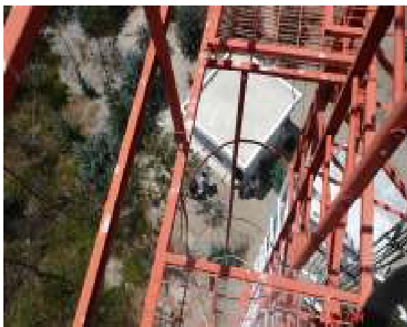
Figura. 6.15. Escalera de Acceso a la torre.
