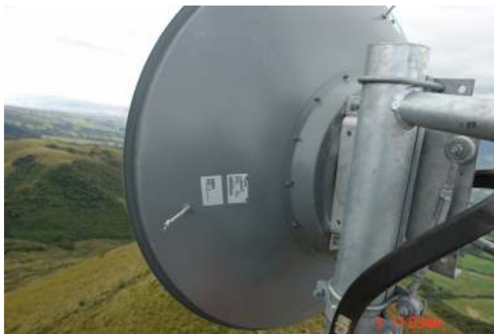
Figura. 6.29. Antena Parabólica.
