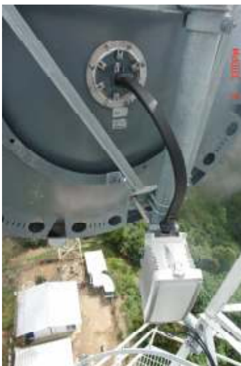
Figura. 6.38. Torre Antena Parabólica, enlace Cerro de Osos – Bombolí y Preanplificador.
