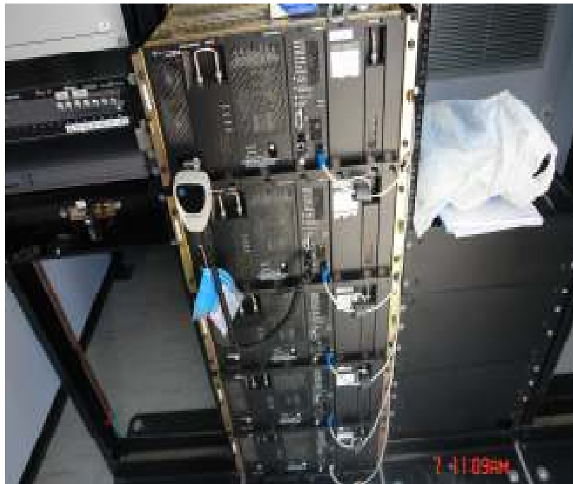
Figura. 6.2. Sistema de Repetidores y Combiadores.
