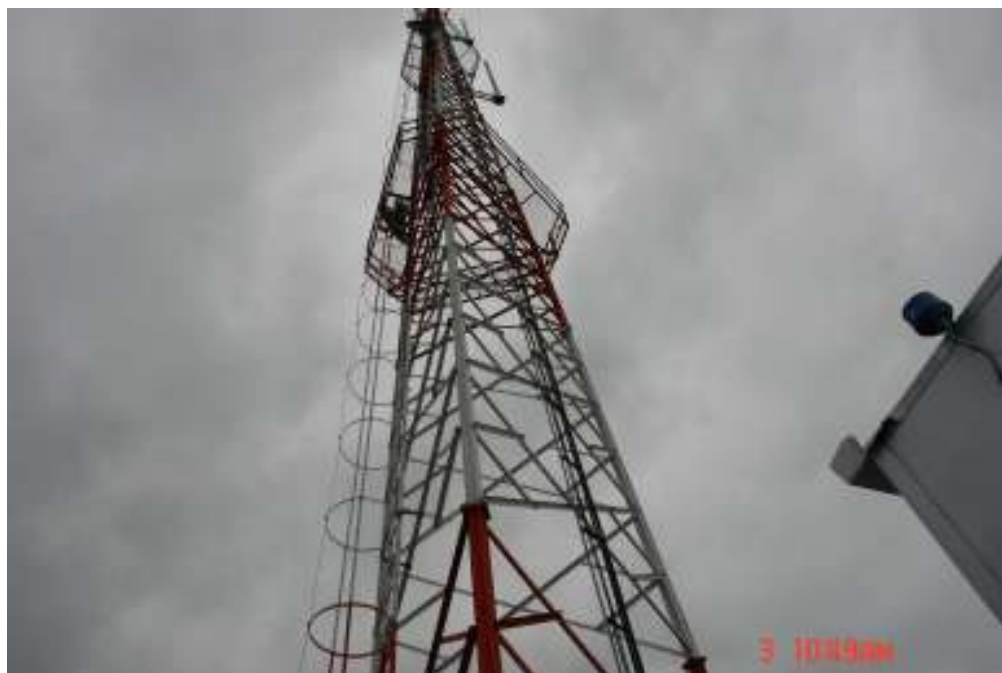
Figura. 6.28. Torre Autosoportada.
