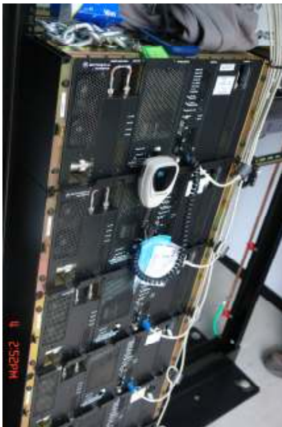
Figura. 6.36. Sistema de Repetición.
