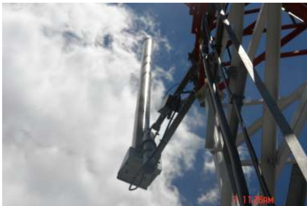
Figura. 6.10. Antena de transmisión de radio frecuencia
