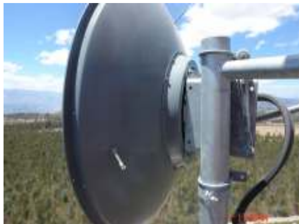
Figura. 6.12. Antena Parabólica, enlace Mitaloma – Puengasí.
