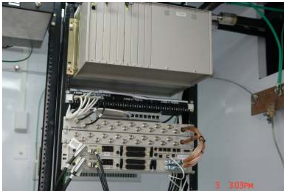
Figura. 6.32. Sistema de Multiplexación, Sistema de Microonda.
