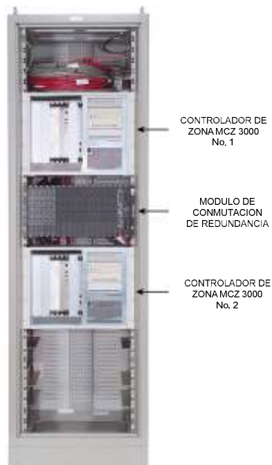
Figura. 2.16. Controlador de zona MZC 3000 en configuración redundante
