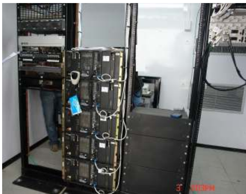
Figura. 6.31. Sistema de Energía, Sistema de Repetición, Combinadores.
