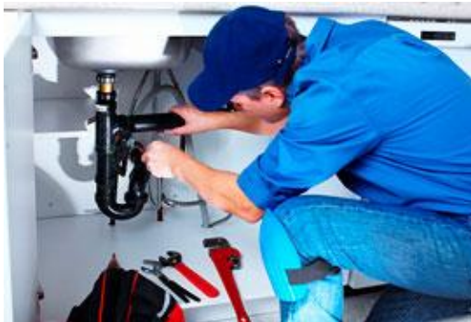
Inspecciones preventivas de las tuberías
