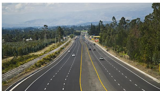
Figura N° 1. 14 Ampliación a 6 carriles Jambelí – Latacunga
