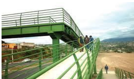
Figura N° 1. 13 Fabricación y montaje paso elevado del ferrocarril (Salcedo)
