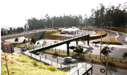
Figura N° 1. 11 Fabricación y montaje puente peatonal de Oyacoto-Calderón (Quito)
